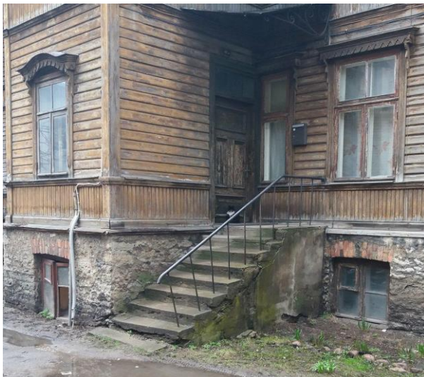
23. Välitrepp ja varikatus hoone esiküljel
