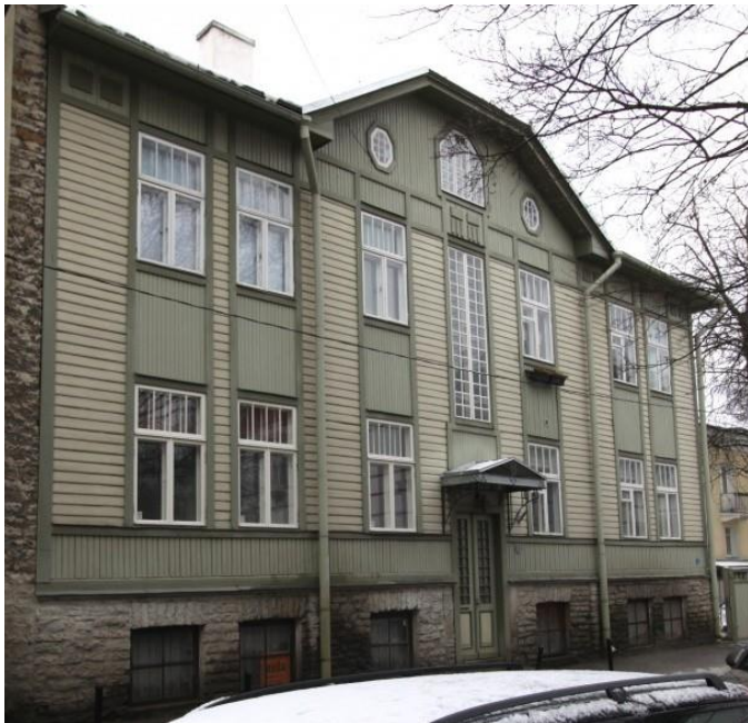
13. P. Süda 8 fassaad
