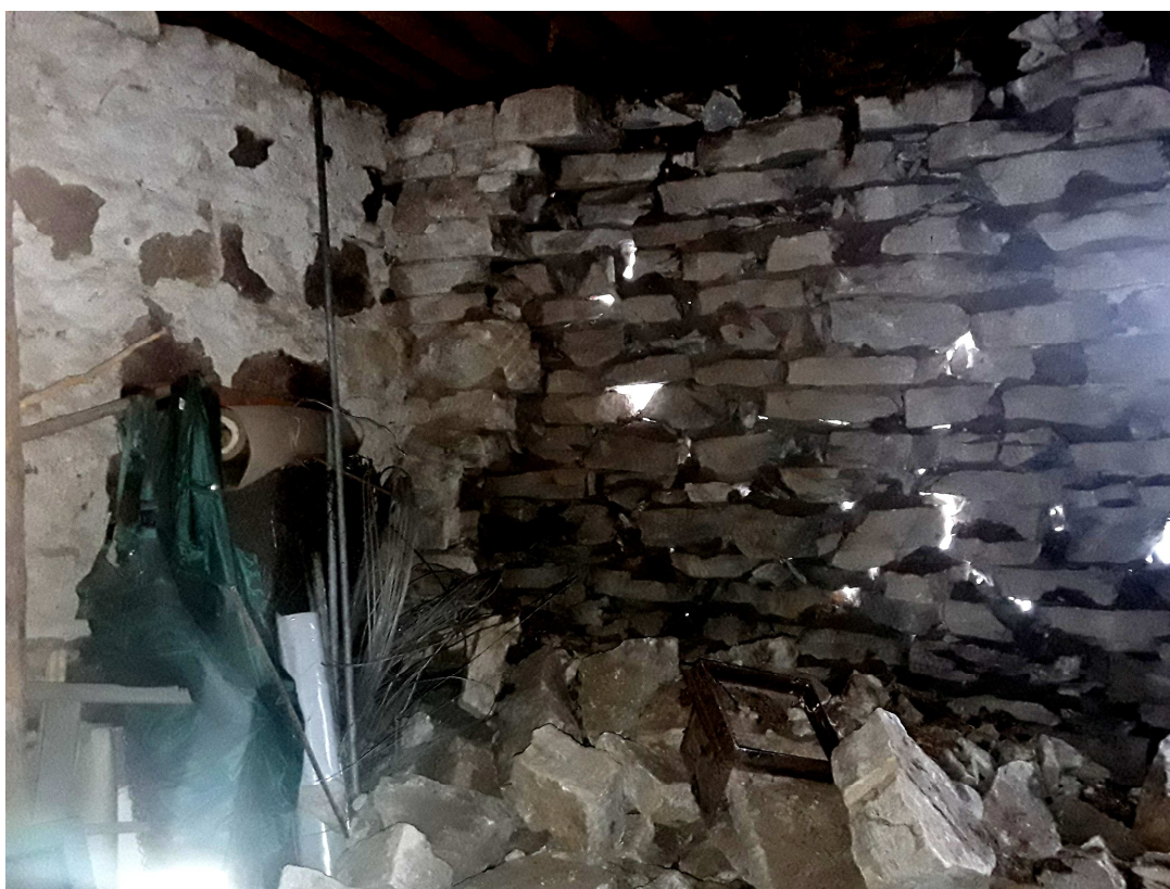
28. Lagunenud põhjapoolne sein, vaade seest.
