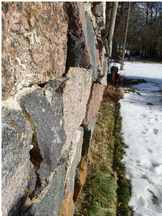
23. Lagunenud läänepoolne sein akna all, külgsvaade.
