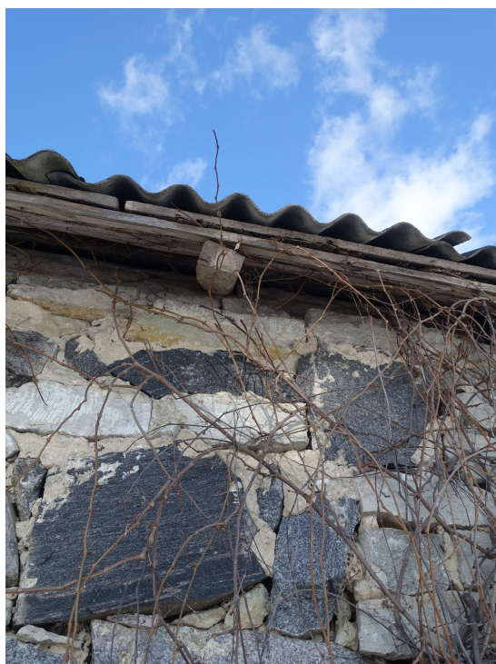
30. Läänepoolse seinä ülaosa ja sarikaots.
