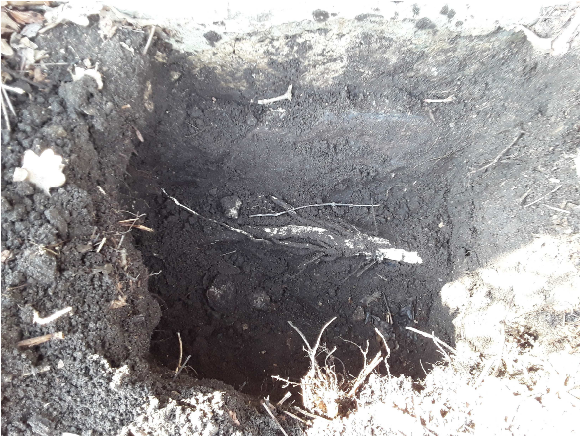
59. Lõunapoolse šurfi üldvaade peale valmimist, näha juured piki vundamenti.
