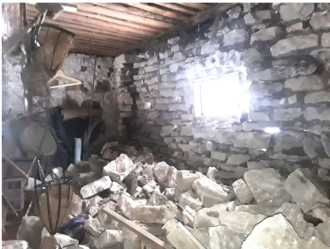
26. Lagunenud põhjapoolne sein, vaade seest.
