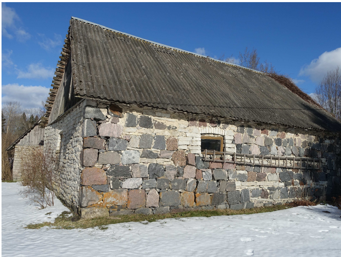
29. Läänepoolse seinä üldvaade.
