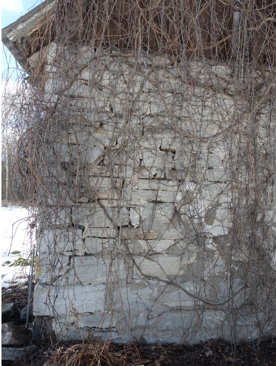
16. Müüritise mördi puudumine lõunapoolsel seinal vasakul. 17. Edelapoolne nurk, näha seina kahjustused.
