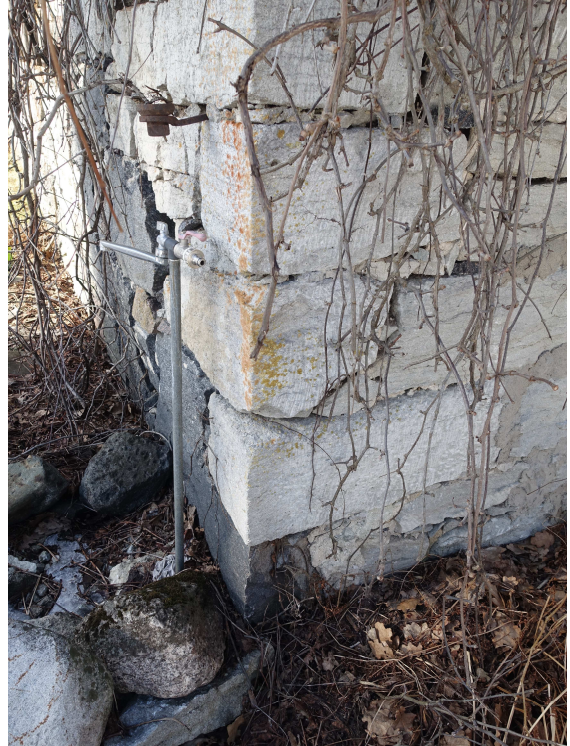
16. Müüritise mördi puudumine lõunapoolsel seinal vasakul. 17. Edelapoolne nurk, näha seina kahjustused.
