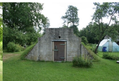
14. 1920. aastate betoonkehandiga kelder
