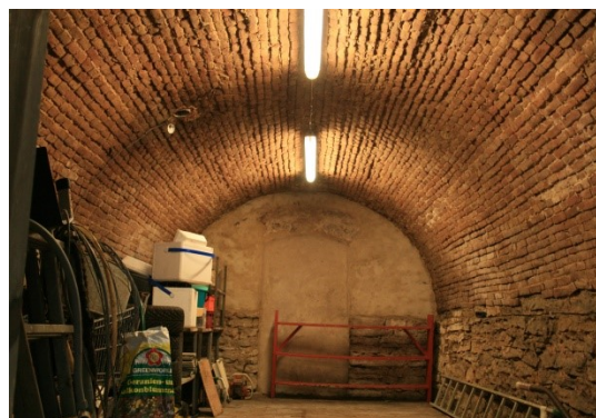
22. Direktori elamu keldri tellistest silindervõlv.
