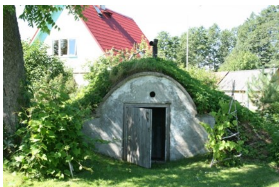
32. Esisein- vahesein- võlv tüüpi ventilatsioon.
