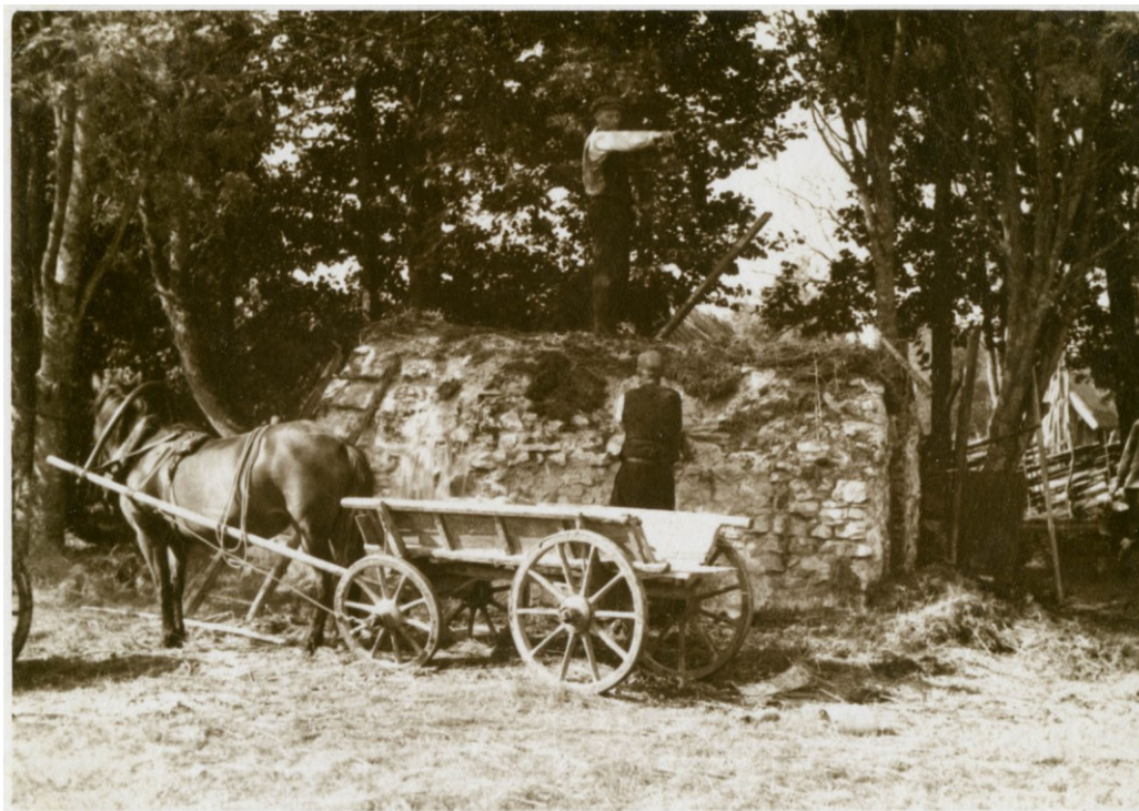
7. Helene Fendti foto töödest keldrikatusel (võimalik, et eemaldatakse keldri katteks olnud õlgesid ja roove).
