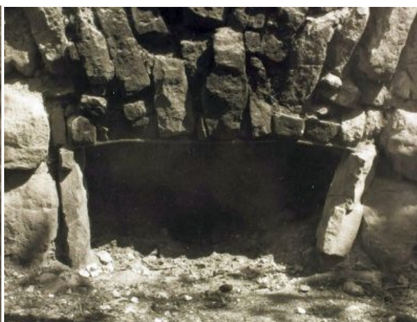
3. Tõrvaahju teraslatiga sillatud koldeava.
