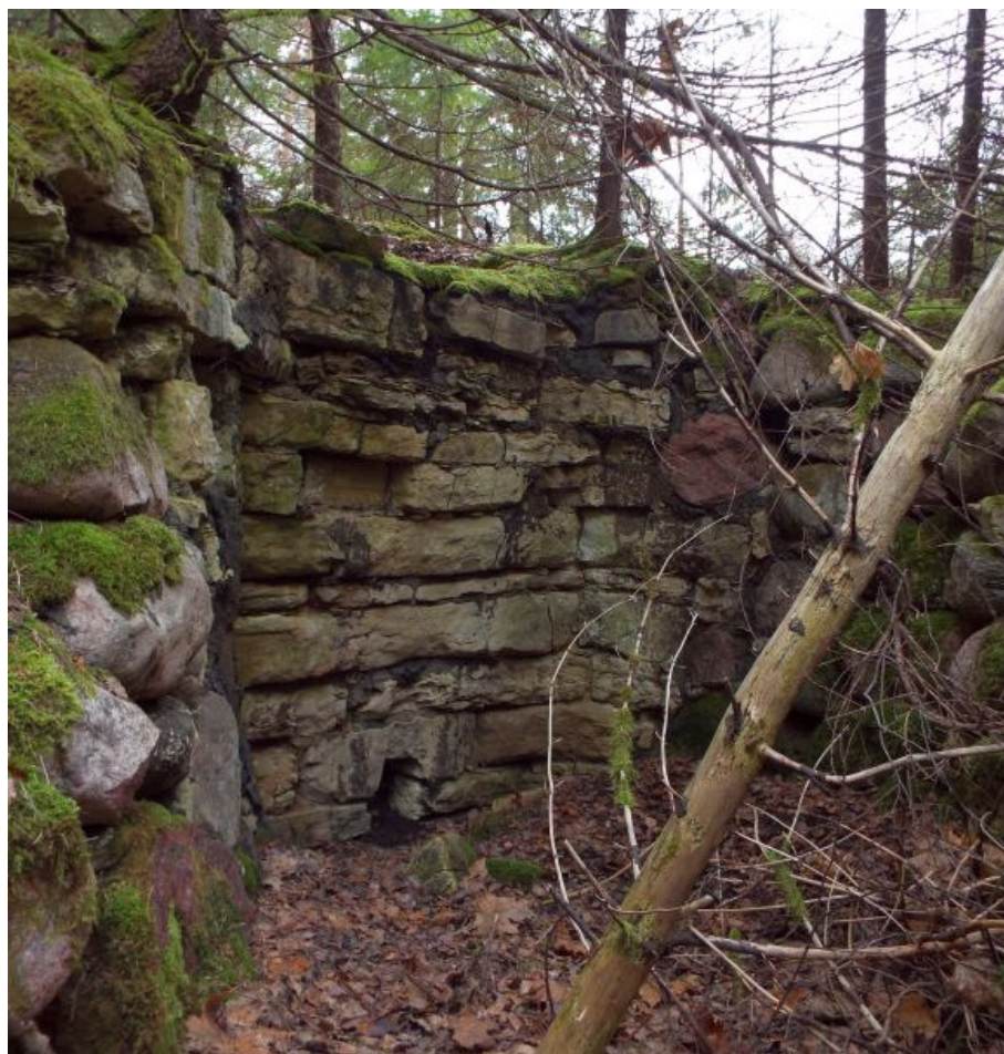
28. Kaerpõlde tõrvaahju tagakülje kiht-kihis paeladu ja selle üleminek raudkividega vooderdatud mulleteks.
