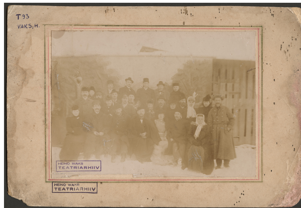
Foto 10 Kujutise kontrastsus on langenud ning see on muutunud kollakas-rohekat tooni, taevast ja lund on jäänud valgeks. Kahjustusaste 3 – kujutis võib ebastabiilsetes tingimustes hävida.
