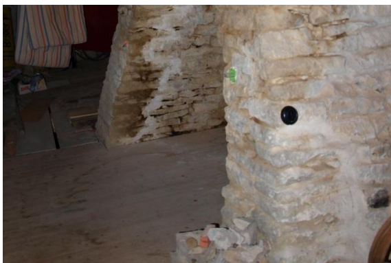
36. Pulli köstrimaja süvistatud elektrijuhtmed. Orissaare vald.
