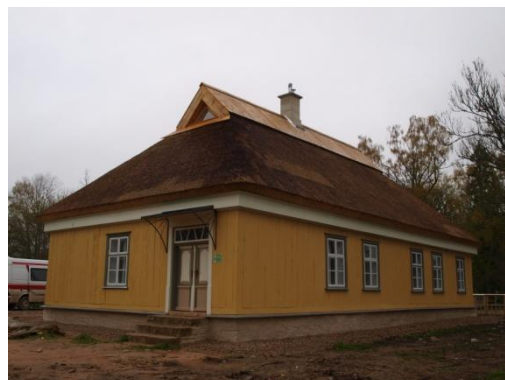
5. Kotlandi mõis (ehitatud 1818, tõenäoliselt 1840. aastatel suuresti ümber ehitatud).
