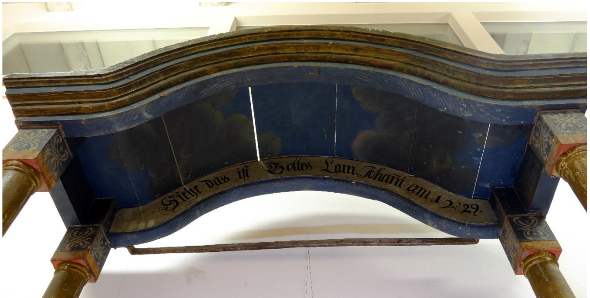
Baldahiini katuse sisekülg. Värvipritsmid.
