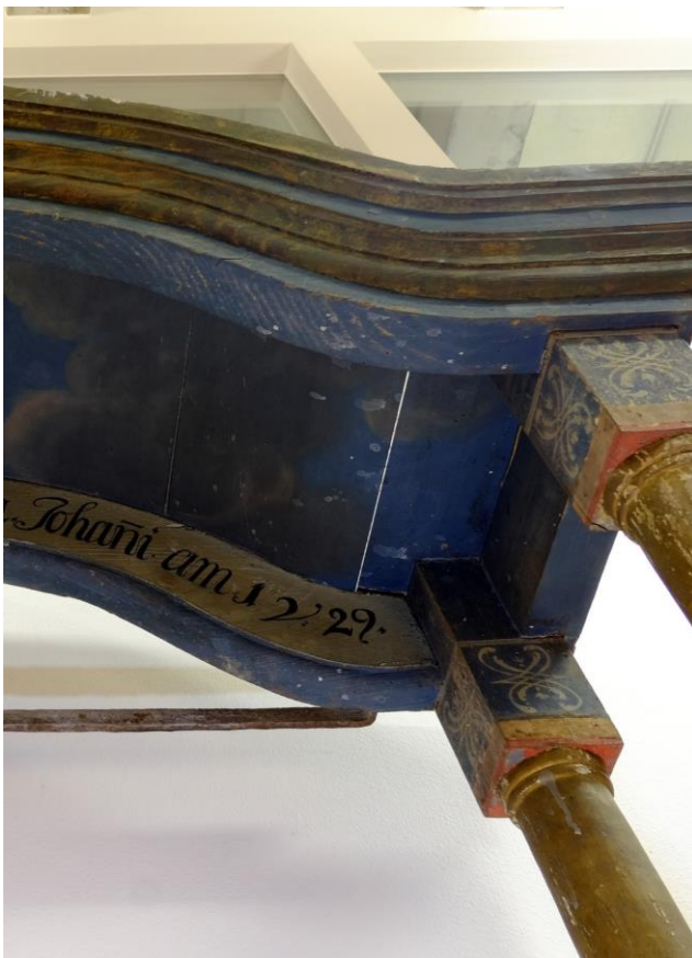
17. Valged pritsmed baldahhiini laes ja lahtine värv kapiteelide all.
