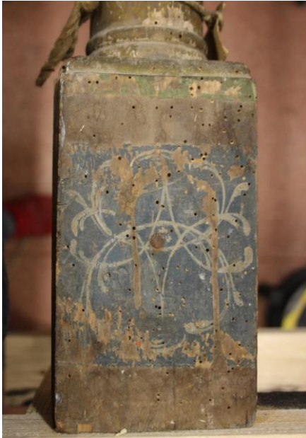
16. Naelaga kinnitatud detail piilari baasil. Putukate väljalennuavad.
