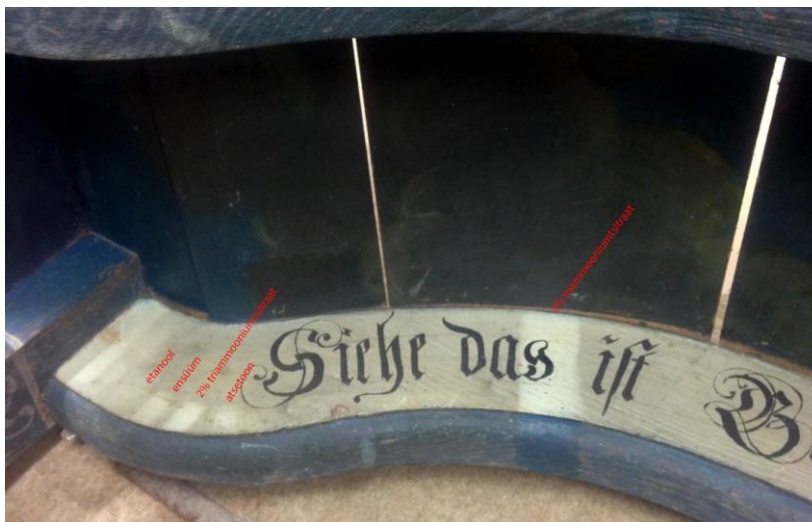
26. Puhastusproovid baldahhiini katuse siseküljel.
