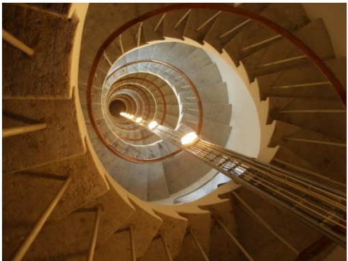
Vaade torni ülaosast alla.
