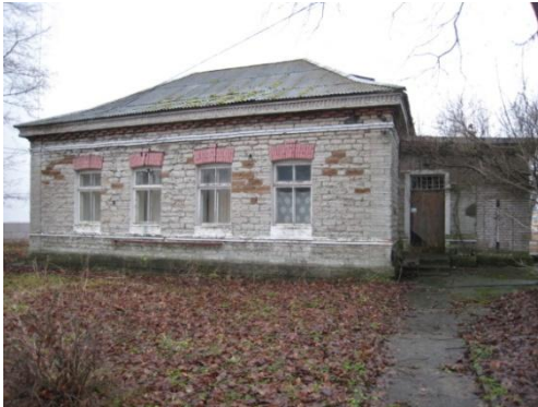
Vaade generaatorihoonele loodest.
