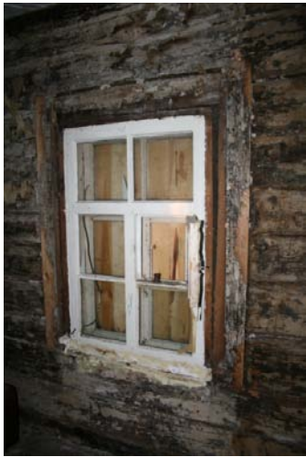
Ill. 20 Originaalne aken, siseraami ja metalldetailidega.
