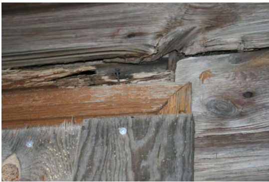
Ill. 11 Katkine akna sandrik ning profileeritud akna piirdeliistud
