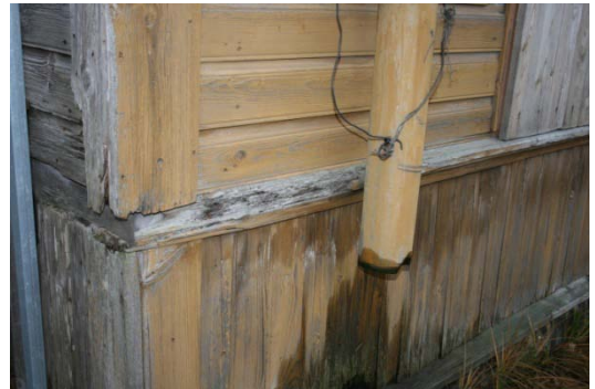
Ill. 14 Katkine vihmaveetoru ja niiskuskahjustus.
