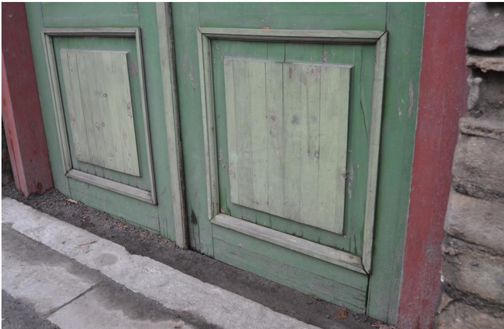
50. Tööstuslikust liimkilbist valmistatud viilung ei pea välitingimustes kaua vastu. Ebaõnnestunud materjalivaliku kõrval mängib olulist rolli ka vähene hooldamine (Tulika 26).
