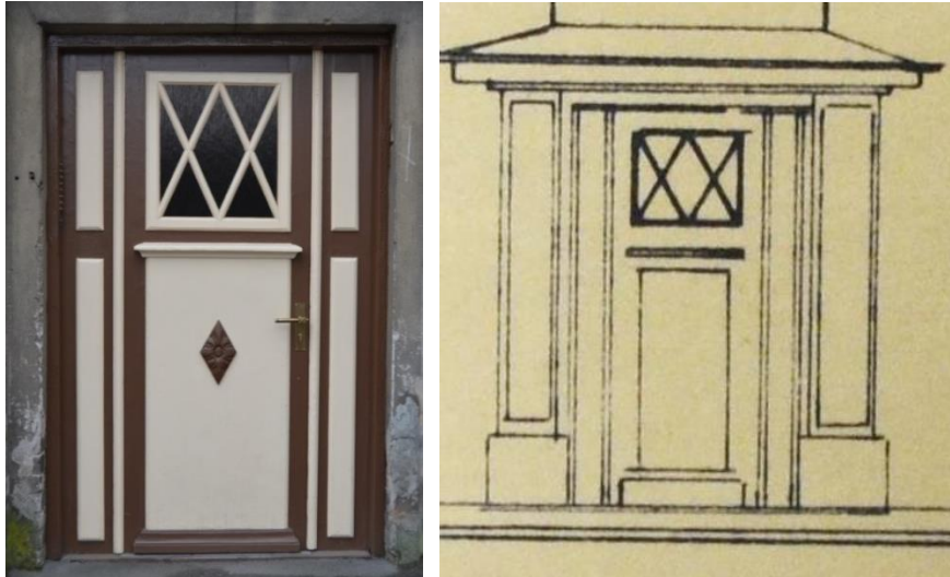
47—48. Aasa 7 ukse võrdluses sama hoone algse ehitusprojekti joonisega. Üldjoontes projektijoonisega sarnase ukse erinevused võib kanda joonise mõõtkavast tuleneva väikese detailsusastme arvele.
