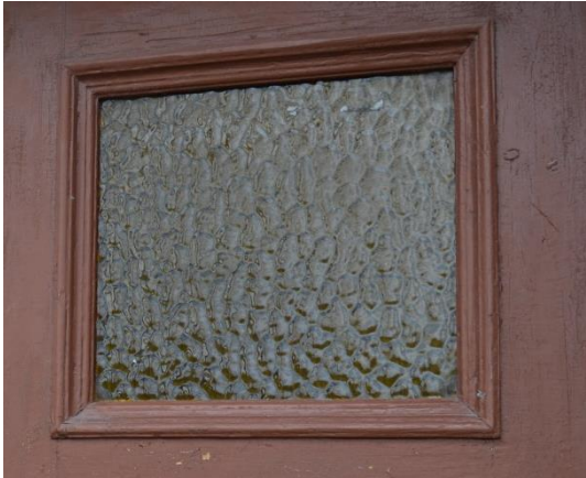
57. Pressitud musterklaas Veerenni 35 tahvelukse ülsaosas.
