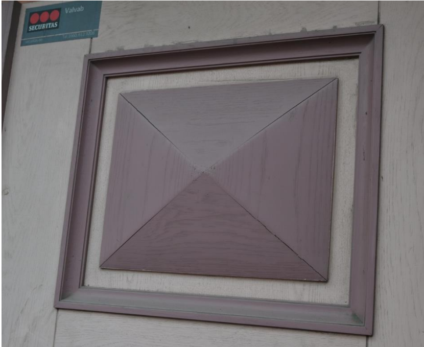
51. Tulika 8 välisukse viilungi püramiidjas ehisdetail. Erinevalt ajaloolisest lahendusest eri tükkidest kokku pandud detaili osade vahele on tekkinud näotud vahed, viimased kiirendavad omakorda niiskuskahjustuste teket.
