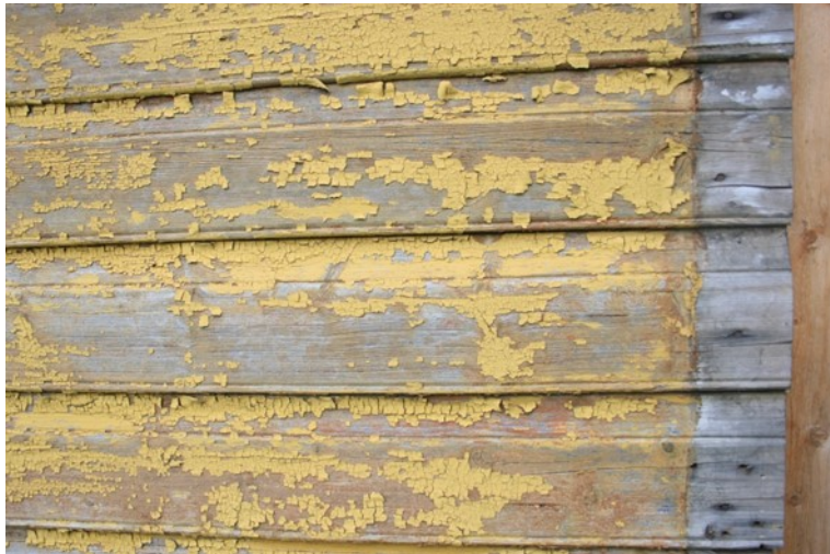
21. Tüüp 1.1 voodrilaud Uus 8 (1928) fassaadil.
