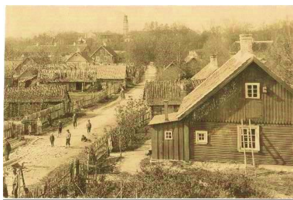
4. Rootsi tänav Kärddlas. Tagaplaanil kalevivabrik.
