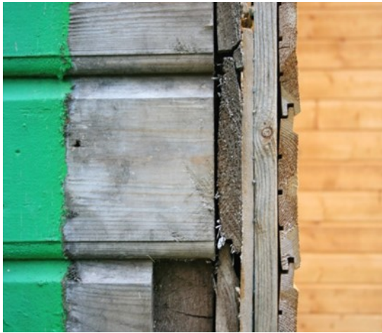
44. Uute laudade kõmmeldumine.
