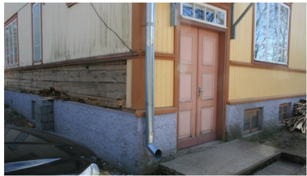
13. Vooderdusviis töölistmajal (Kõrgessaare mnt 6, 1884). 14. Palkide vahetamisel eemaldatav püstvahevöö (Uus 3, 1935).
