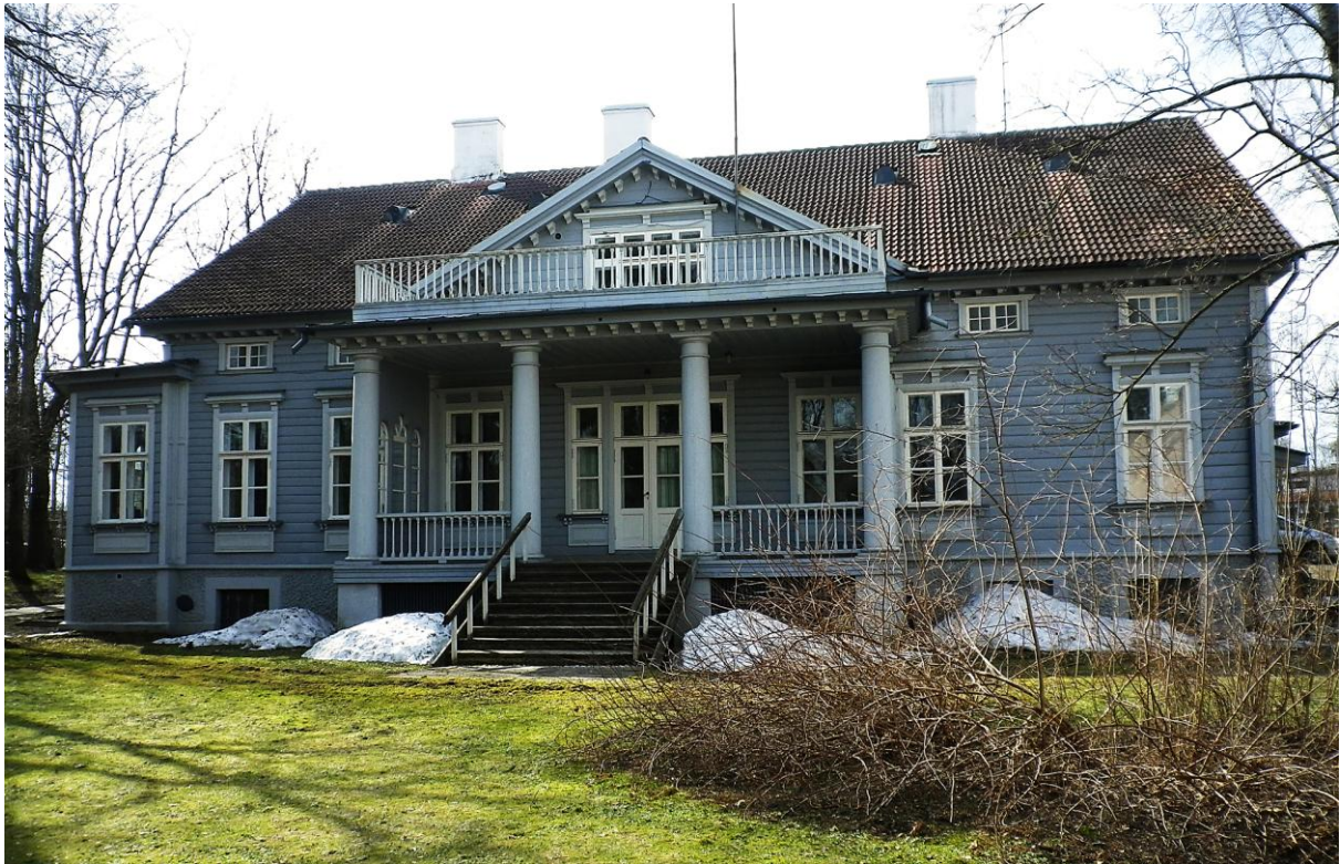
11. Vaade Baeri majale idast. Klaasitud tahveluksed, trepp, akna piir- ja veelauad on sootuks erinevad algupärasest. Foto, 2011 kevad.
