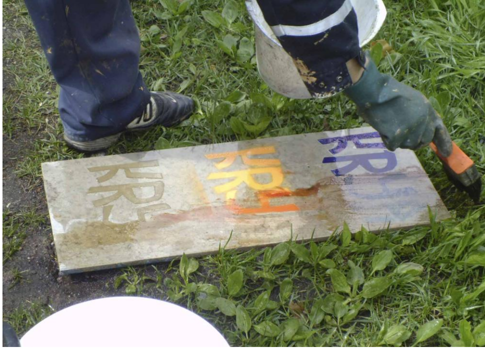
12. Graffiti varju eemaldusvahendi kandmine paeplaadile – aine, mis peaks eemaldama sügavamatesse pooridesse imbunud värvijäägid.
