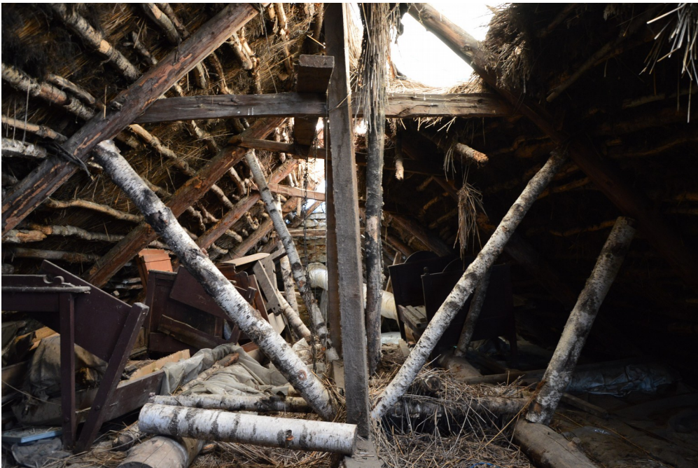
Illustratsioon 27 Katusealune vaade põhjast lõunasse
