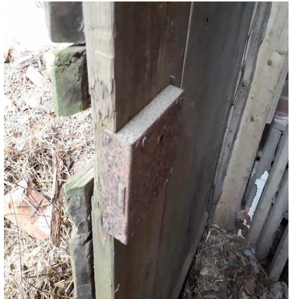
28. Uksel on latthinged. 29. Vaheukse ees olev lukk ei ole ehitusaegne, kuid on suhteliselt vana
