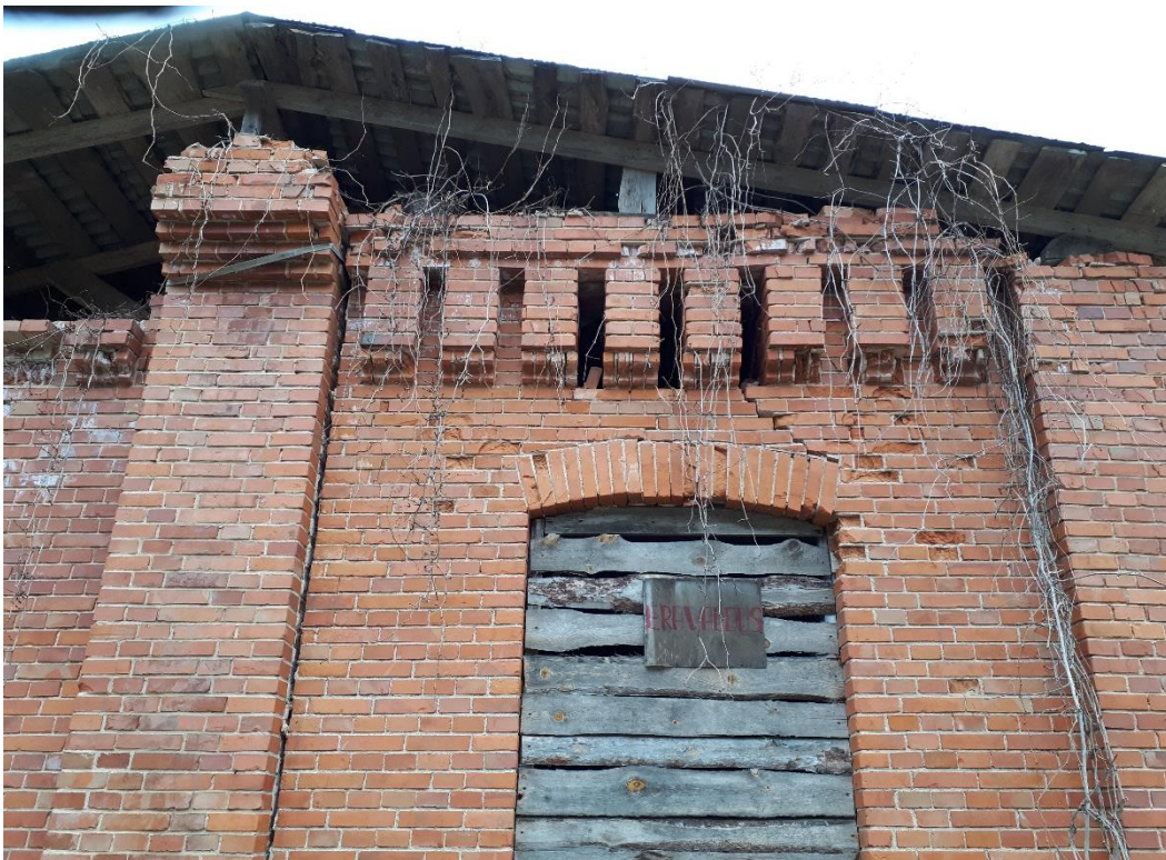
12. Tellistest hammasfriis akende kohal on laotud koos täisladumisega pärast tellispostide ehitamist. Edelakülje parempoolse akna kohal on hammasfriiside vahel tuulutused
