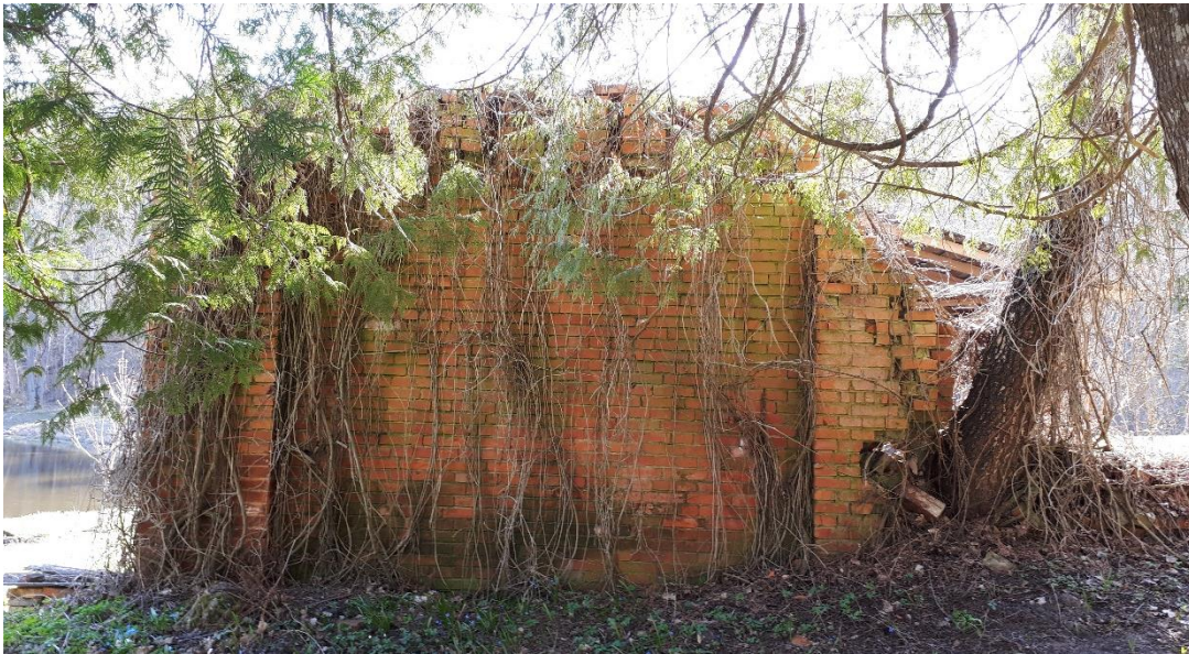
17. Müüritise seisukorda halvendavad sellel kasvav taimestik ja vundamendil kasvav puu
