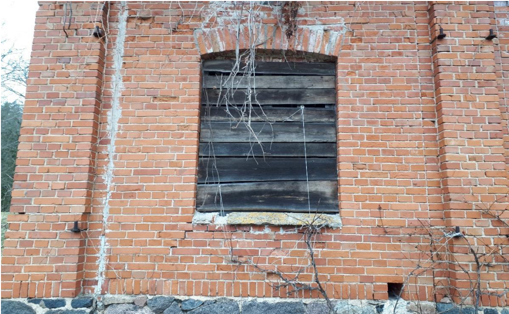
24. Hoone esifassaadi vasakpoolsele aknale on lisatud tsemendist veenina
