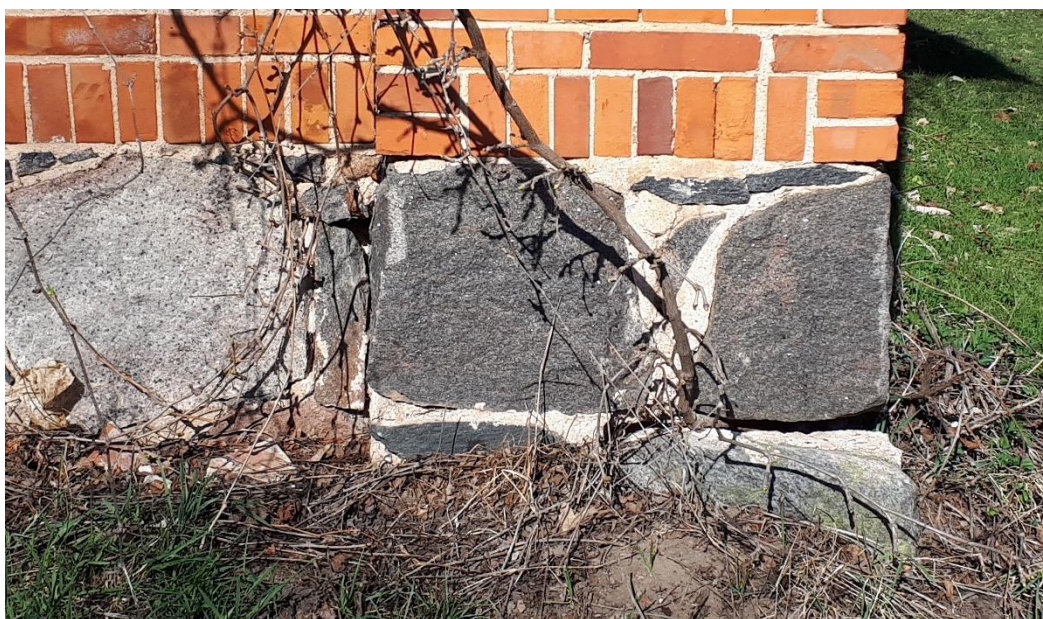
9. Üksikutes kohtades, kus vuukidest on segu eemaldunud ja taimestik läbi kasvanud, vajab sokkel parandamist
