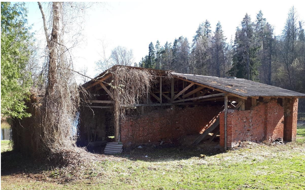
23. Vaade hoonele põhjast
