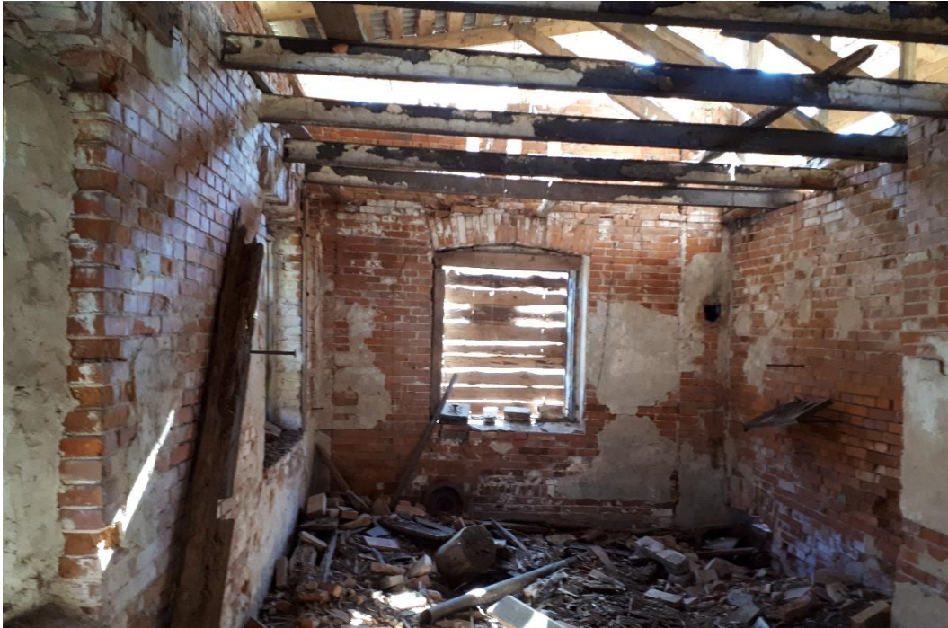
22. Terasest laetalad ja ehituspraht müüride vahel
