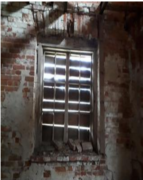
25. ja 26. Säilinud aknaraamid on hilisemad, ühtegi aknatappi ega hinge ei ole, raamid on eest tõstetavad. Kaarsillustes olevad tellised on halvas seisukorras
