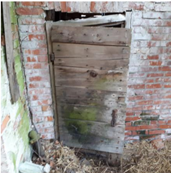
28. Uksel on latthinged. 29. Vaheukse ees olev lukk ei ole ehitusaegne, kuid on suhteliselt vana
