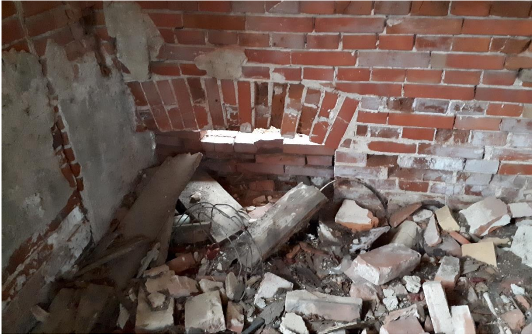
19. Vaheseina allosas olev suur sillusava
