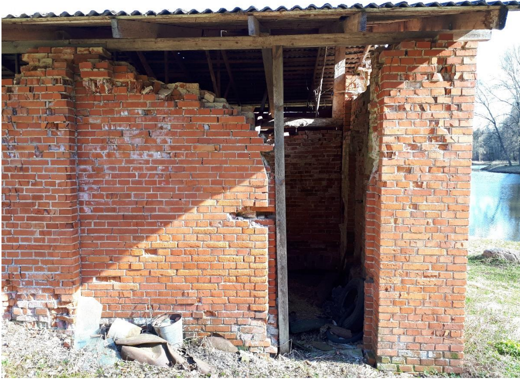
27. Ukseava hoone tagafassaadil on ehitusaegne, avatäidis puudub
