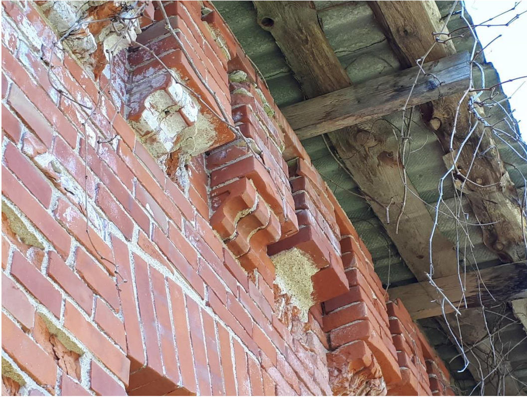
13. Hammasfriis toetub profiiltellistele. Parandused on tehtud tsemendiga
