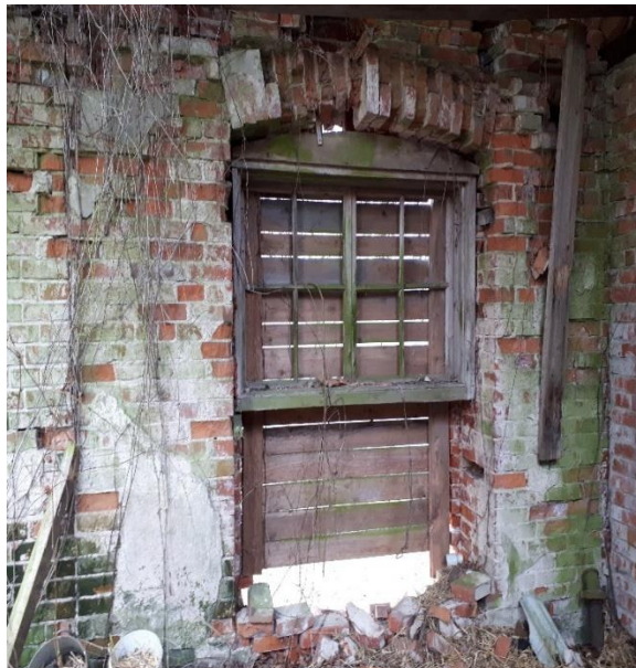
25. ja 26. Säilinud aknaraamid on hilisemad, ühtegi aknatappi ega hinge ei ole, raamid on eest tõstetavad. Kaarsillustes olevad tellised on halvas seisukorras
