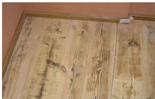
Foto nr.34. Vana puitpõrand pärast puhastamist, enne õlitamist
