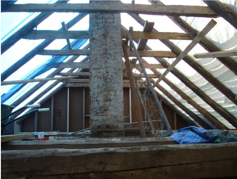
Foto nr 9. Pööningu konstruktsioon
