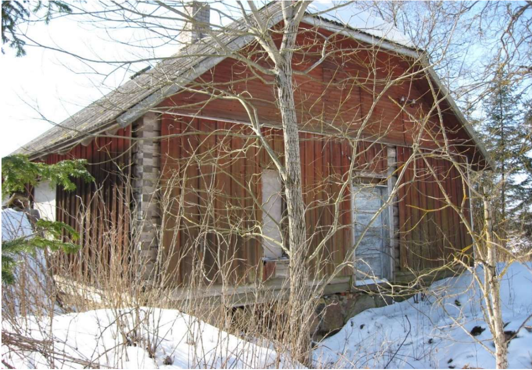
Foto nr 2. Eluhoone aastal 2009 märts, vaade kirdest
