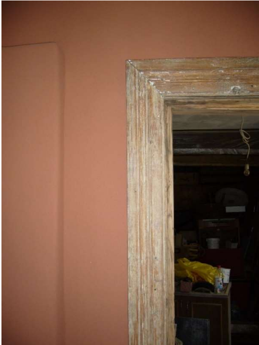
Foto nr.31. Uus savikrohv ja värvist puhastatud siseuks
