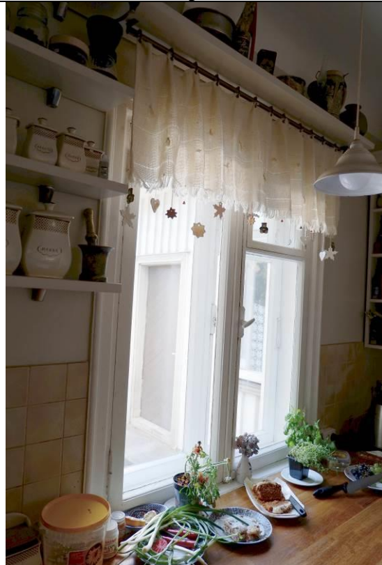
26. Akna A-14 sisemised piirdeliistud
