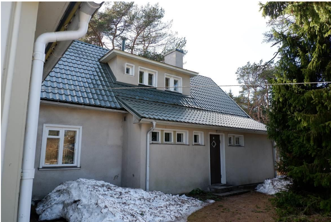
42. Vaade tagumisele sissepääsule tagahoovi poolt.
