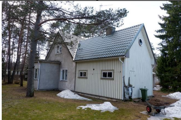
17. Katteliistuga fassaadi puitvooder
