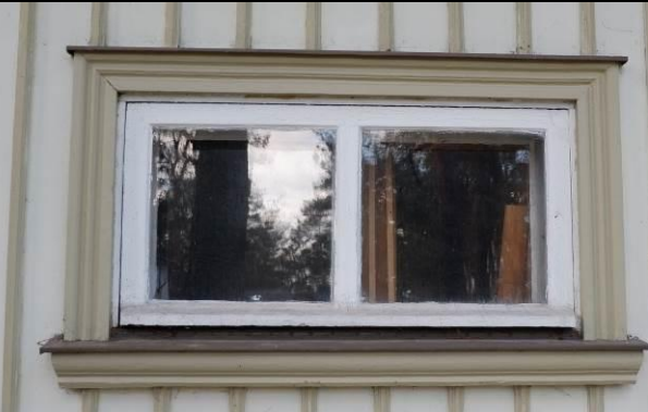
17. Katteliistuga fassaadi puitvooder
