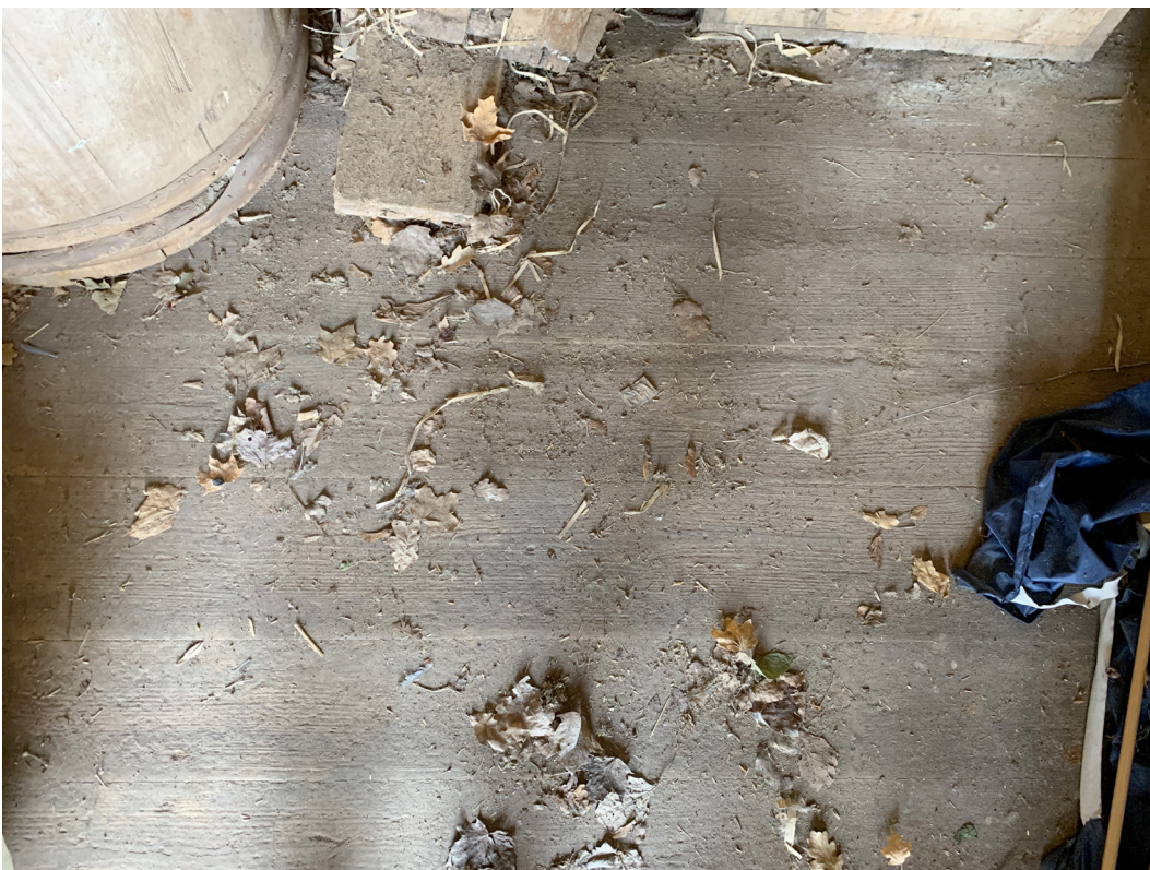
27. Foto, põrand ruumis nr. 4, aprill 2019
