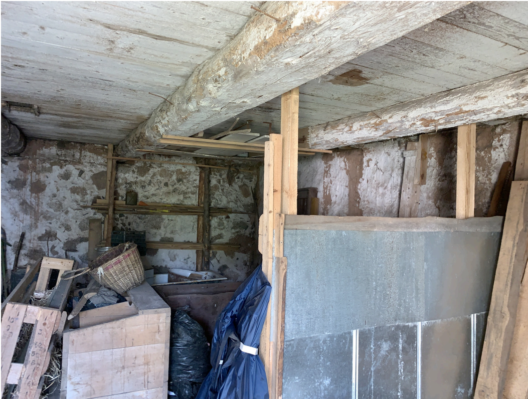
26. Foto, lagi ruumis nr. 4, aprill 2019
