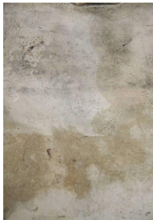
4. Laiguline kivipind võib olla põhjustatud kivis olevast niiskusest, 20. X 2011.
