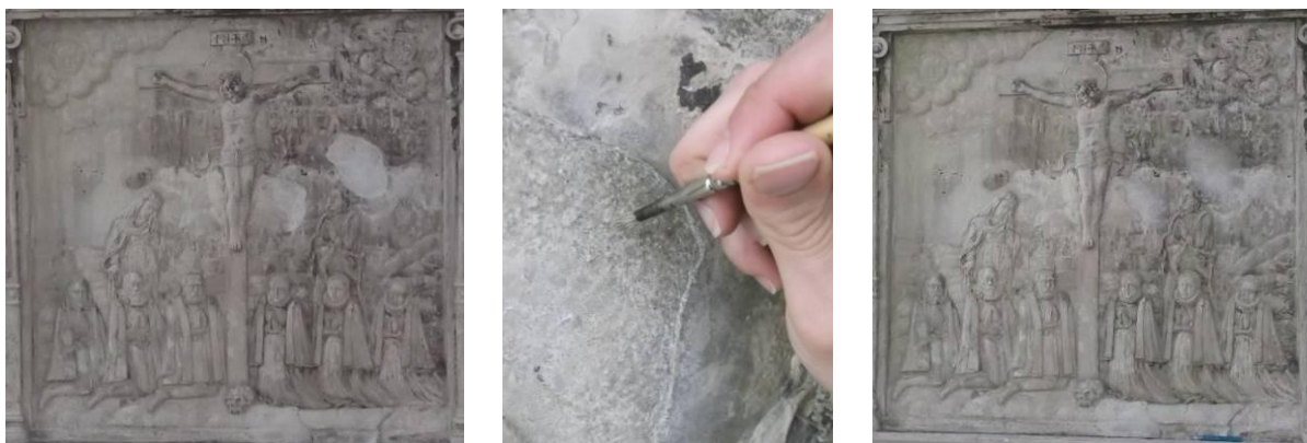
18. Epitaafi lokaalne toneerimine. Detail epitaafilt enne(vasakul) ja pärast (vasakul) toneerimist, 21. V 2012.
