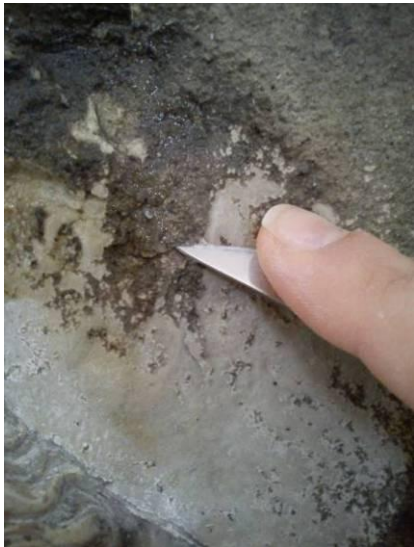
13. Sekundaarsete kadudeparandusete tsementkrohvi eemaldamine skalpelliga, 28. III 2012.
