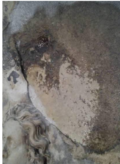
14. Eemaldatud tsementkrohvi alt ilmus välja hele kivipind, mis vajas toneerimist, 28. III 2012.
