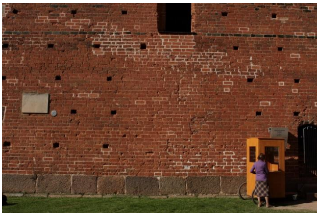
30. Heleda mördiga vuugitud asendustellised Tartu toomkirikus.
