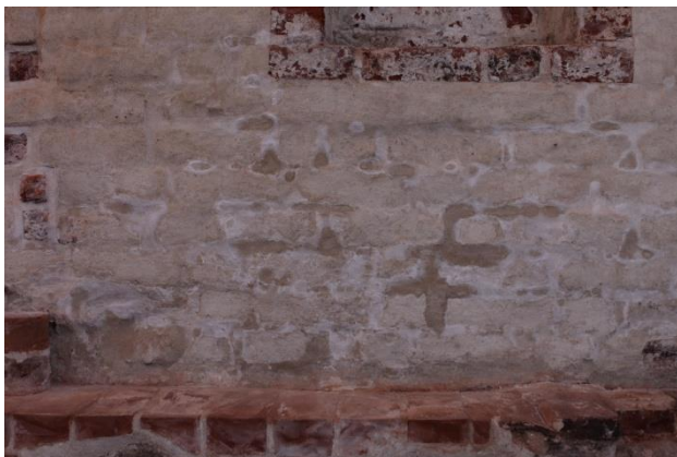
12. Ohverkrohv. Tartu Jaani kirik, põhjakõrgsein 2012.
