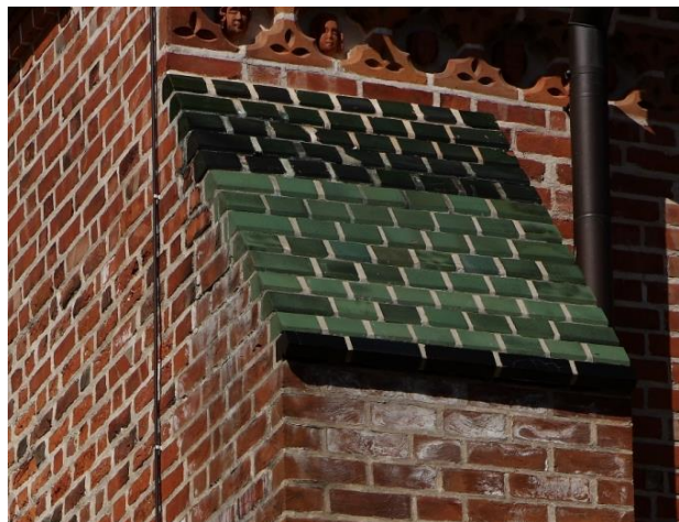
32. Glasuurtelliste asendamine Tartu Jaani kirikus.
