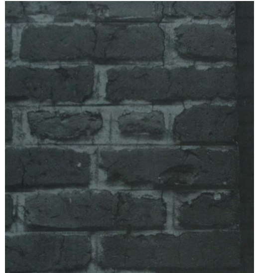
15. Näide tellismüüri parandamisest mördiga.
