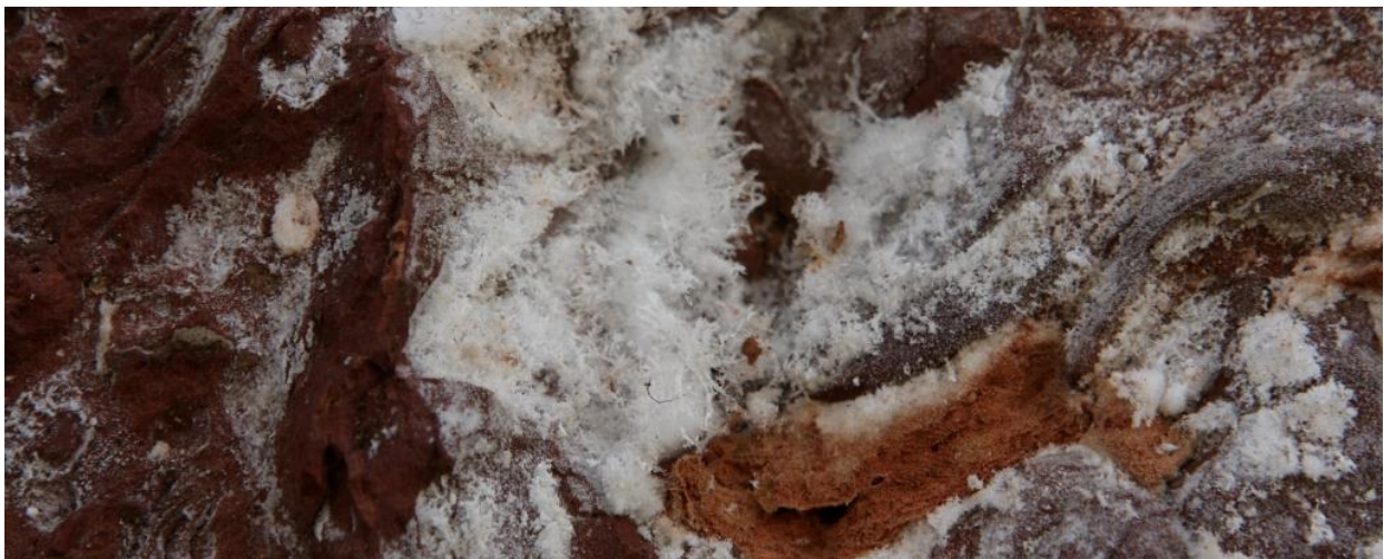
9. Soolade kristalliseerumine tellise pinnal Tartu toomkirikus.
