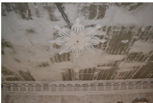
128. Saali betoonlagi karniisidega, rosetiga.
