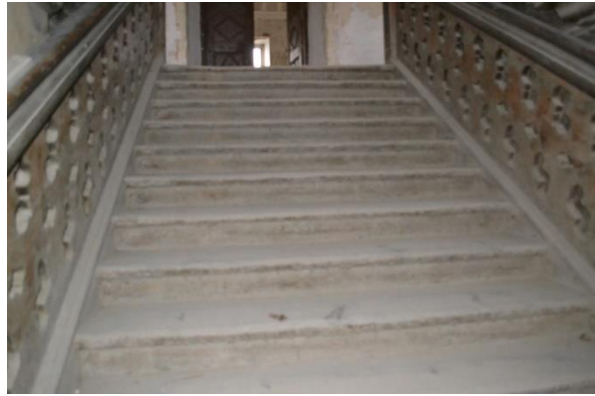
158. Kulunud paraadtrepipi astmed (11a ja 20).
