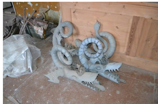
45. Paigaldamist ootavad veesülitid.
