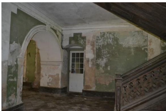
87. Sile peegelvõlviga lagi ruumis 11a.
