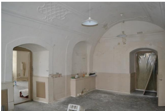
83. Stukkdekooriga silindervõlv ruumis 14.
