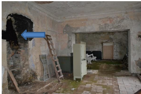
80. Lõhutud ahi ja lõõr 1. korrusel ruumis 12.
