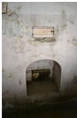
73. Ahjusuu 2. korruse koridoris.
