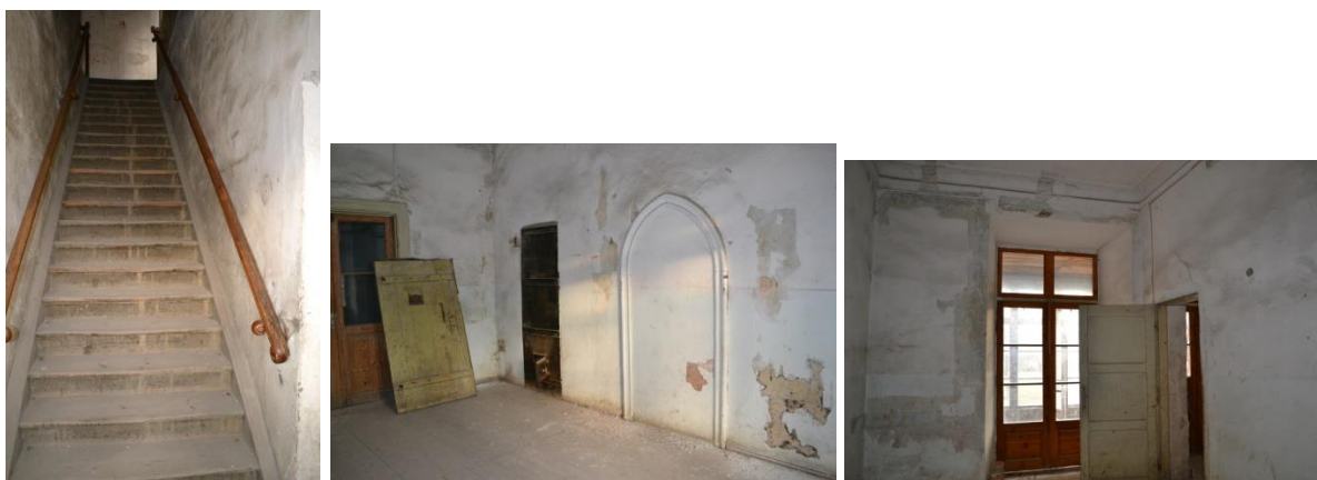
116. Ruumi 19 trepp ja ruum 20.
