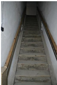
160. Trepp ruumis 16 (1.korrus).
