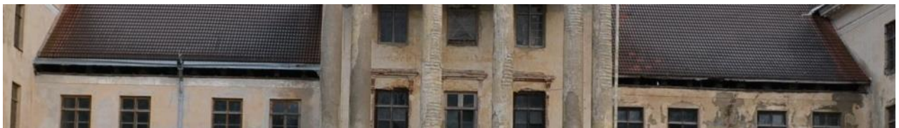
41. Vasakul valtsrenn ja vihmaveetoru, mis paremal puuduvad.
