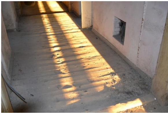
140. Kulunud puitpõrand ruumis 25 (plaanil parem ots).
