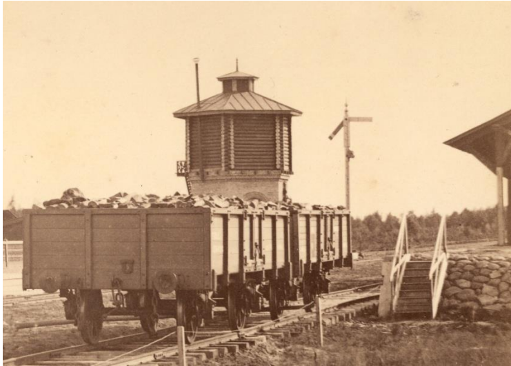
8. Püssi jaam palkidest paagiosaga. Veetorn paikneb rööbastele väga lähedal.
