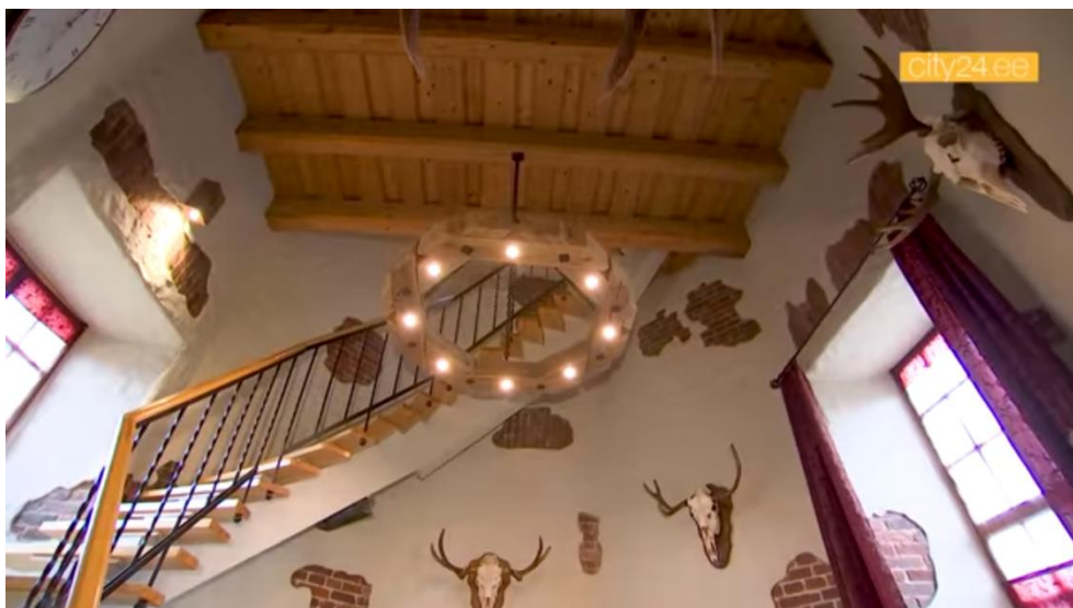
42. Antsla veetorni elutuba ja endise paagi põhja ehitatud vahelagi.
