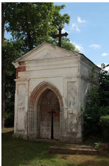
13. Keila kirikuaia kabel 6, 19 saj.
