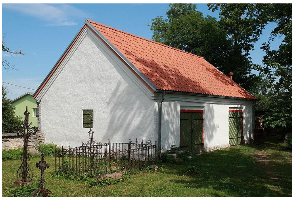
12. Keila kirikuaia kabel 5, 19 saj.
