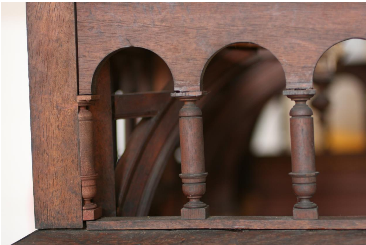
Uus poolpilaster originaalide kõrval
