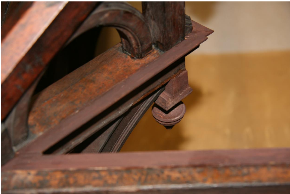
Uued liistud ja rippuv peeker peale retušeerimist akvarelliga
