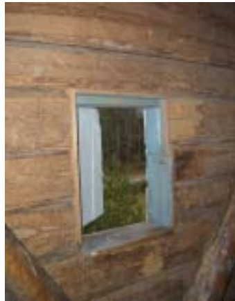
Niiskuskahjustused torni III korrusel, valdavalt luukide ümbruses.
