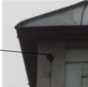
Niiskuskahjustused torni III korrusel, valdavalt luukide ümbruses.
