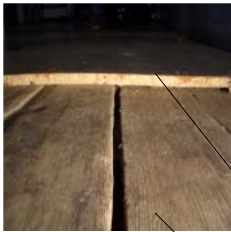
Pikihoone põrand. Lõhestatud plangud, puitkiudpressplaat
