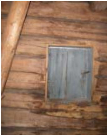
Niiskuskahjustused torni III korrusel, valdavalt luukide ümbruses.
