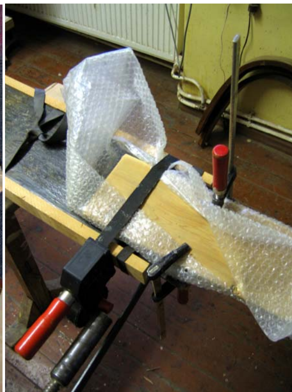
Foto 13: Maria Soboleva. Puitkonstruktsiooni parandamine.
