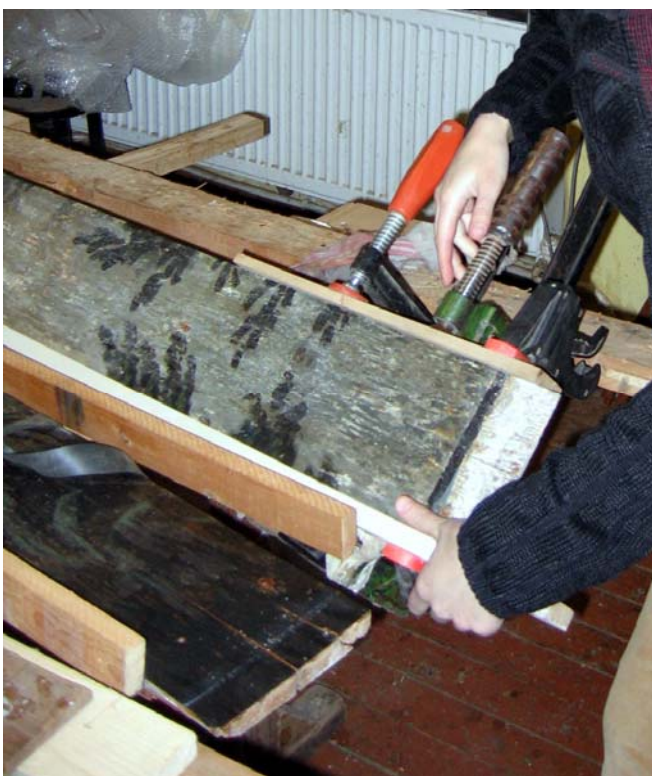
Foto 12: Toomas Marge. Puitkonstruktsiooni parandamine.
