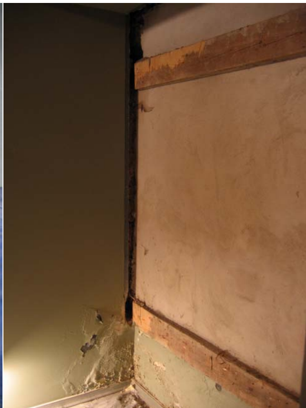
Foto 7: Maria Soboleva. Tsementkrohvisein maali taga ja kaks maali kinnitamislatti.
