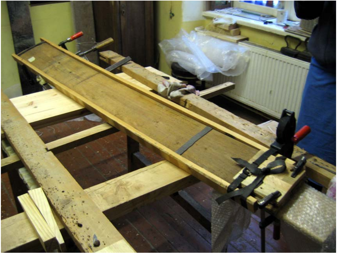
Pilt 20. Maalilaua puitkonstruktsiooni fikseerimine
