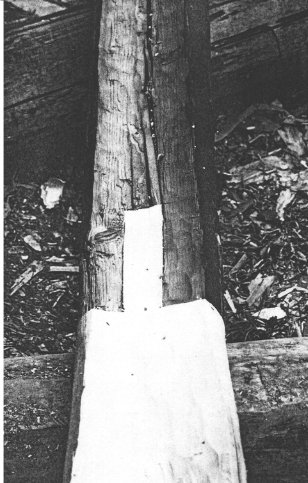
Foto 5.7.1.8.1. Atla-Eeru kõrtsi asenduspaldi ja vana paldi vaheline keeljätik. Allikas: Kilumets 2003
