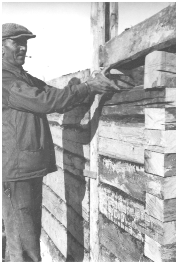
Foto 5.2.2. Vara märkimine uue palkmaja ehitusel 1938. aastal. Tappnurkadega maja ehitusel kasutatakse küljetatud palke ka vanast hoonest. Allikas: ERM fk 828 118. Foto:G. Ränk
