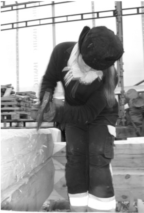
Foto 5.7.1.4.1. Rootslaste palgi tahumine Källunge kirikutorni restaureerimisel. Eesplaanil meister raumiskirvega, tagaplaanil tahumiskirvega. Allikas: Gavel 1993: 7)
