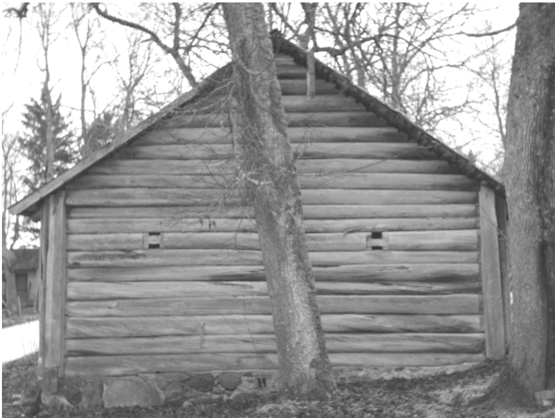
Foto 5.7.1.2.2. Vana ehituspuidu taaskasutamine. Palkviiluga aidahoone Veneveres
