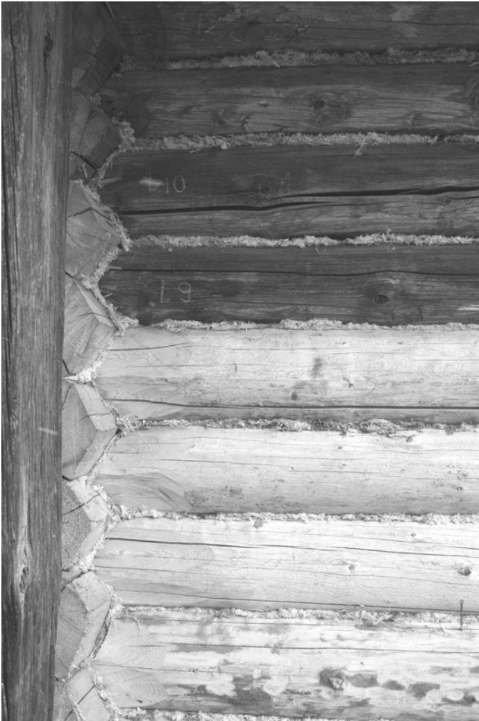
Foto 5.7.1.5.3. Sepa talu rehielamu rehetoa loodenurk (nurk DE). Asenduspalgid järgivad algse nurgaliite tüüpi. Uutele nurgaliitele on tehtud lisatahk üles, mis liite esteetikat veidi muudab.
