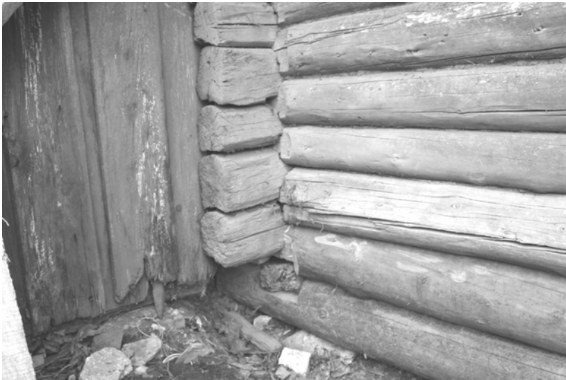
Foto 5.7.1.6.1. Pritsu aida kirdenurk: hoonel on algset lahtine vara, asenduspalkide vahel on kinnine vara.
