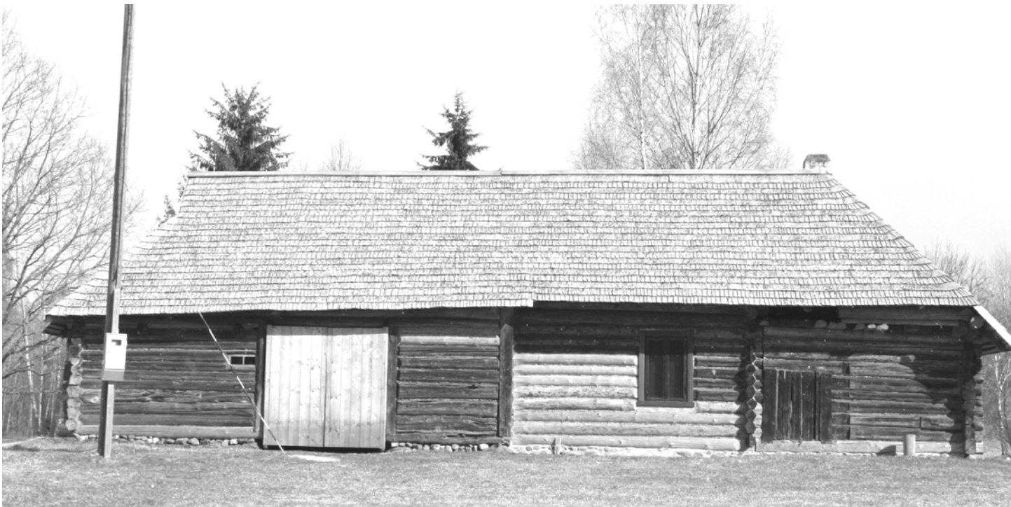
Foto 5.7.10. Sekkumisel tuleb arvestada konstruktsiooni kui tervikuga. Sepa talu rehielamu on ehitatud mitmes etapis, igal etapil on omane tehniline lahendus ja omapärsed nurgaliited. Kõik hoone osad on taastatud võrdväärse meisterlikkusega ja tehniliselt algse eeskujul. Asenduspuiduna on aga kasutatud algse männi asemel metsakuiva kuuske.
