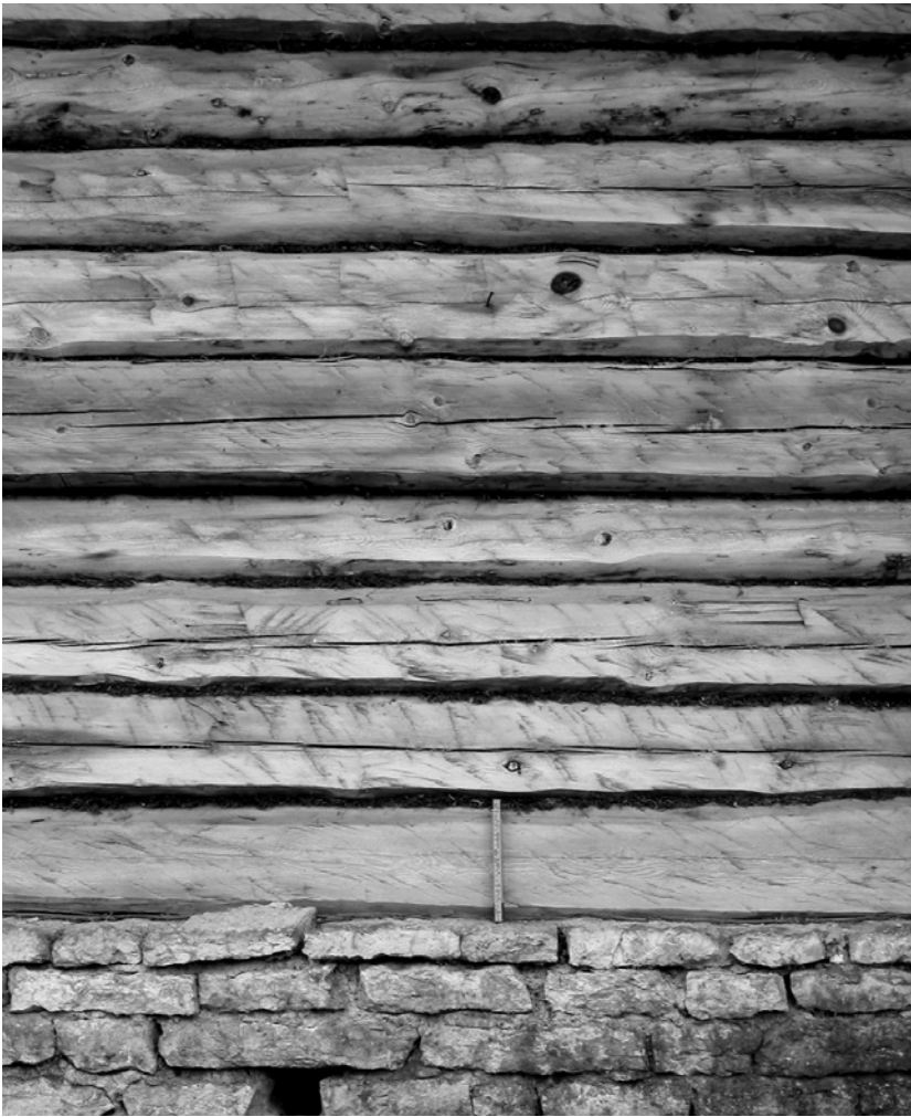
Foto 5.7.1.4.5. Sutlepa kabeli sein D. Kabeli asenduspalkide töötlus vene kirvega. Igal palgil on näha veidi erinev tahumiskäekiri, tahumise nurk ja löögi rütm
