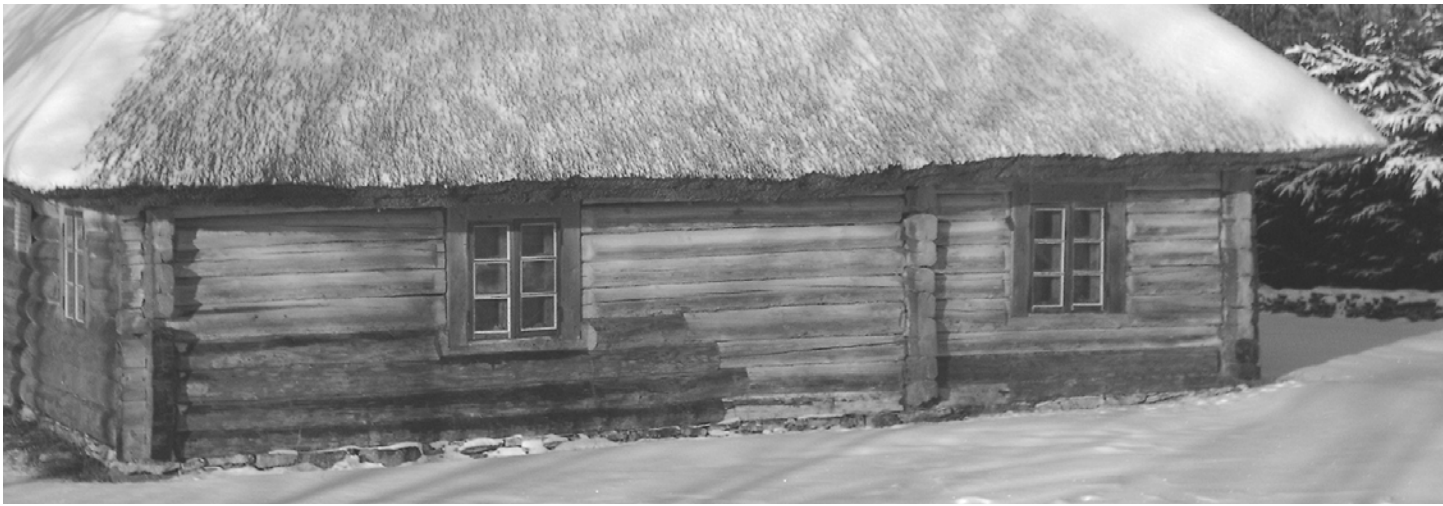
Foto 5.7.9. Originaalse substantsi minimaalne muutmine. Atla-Eeru kõrtsi idaseina alumised palgid on välisnurkadest vahetatud. Vanemad alumised palgid on keskelt säilitatud, võimaldades juurdepääsu hoone vanema konstruktsiooni tõenditeni. Samas: kuivõrd sobib selline taastamine kokku Eesti või kohaliku palkehituse traditsioonidega?
