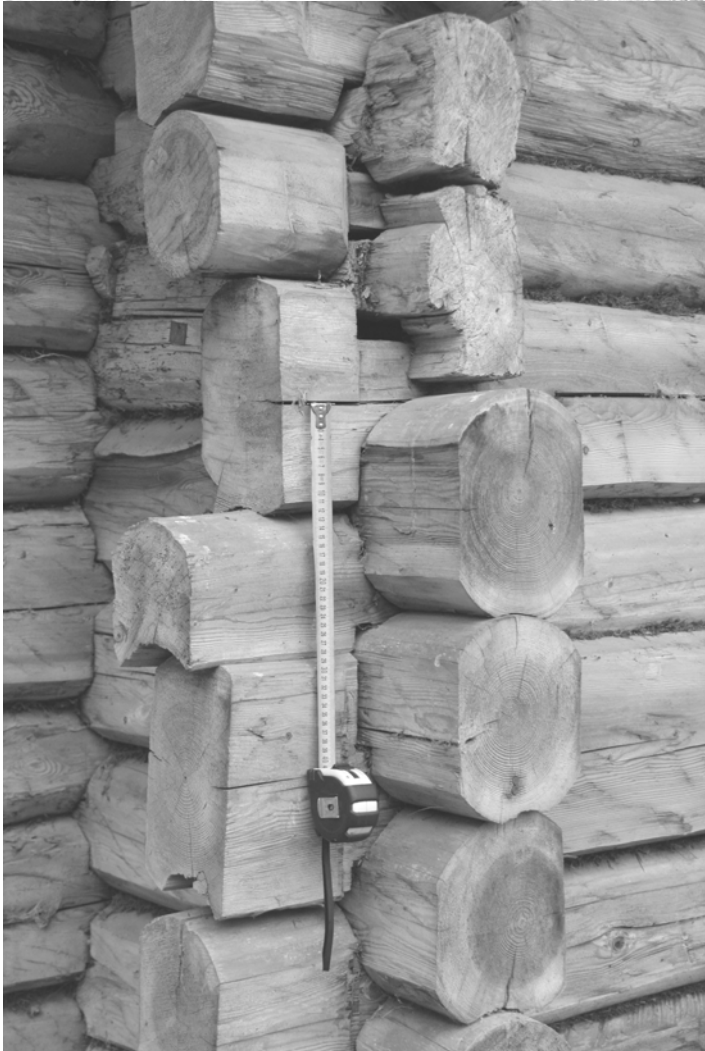
Foto 5.7.1.5.2. Sutlepa kabeli asenduspalkidest nurgaliide BC põhjafassaadil. Eesti vernakulaarse palkehituse traditsiooni iseloomustab teatud lohakus, samas lähtumine olemasolevast, ehitamise ratsionaalsus ja piisav täpsus. Oleks vale seda traditsiooni muutma hakata. See-eest nurgaliidet on vaja täpselt kopeerida, kuna see palkhoone iseloomulik detail on.
