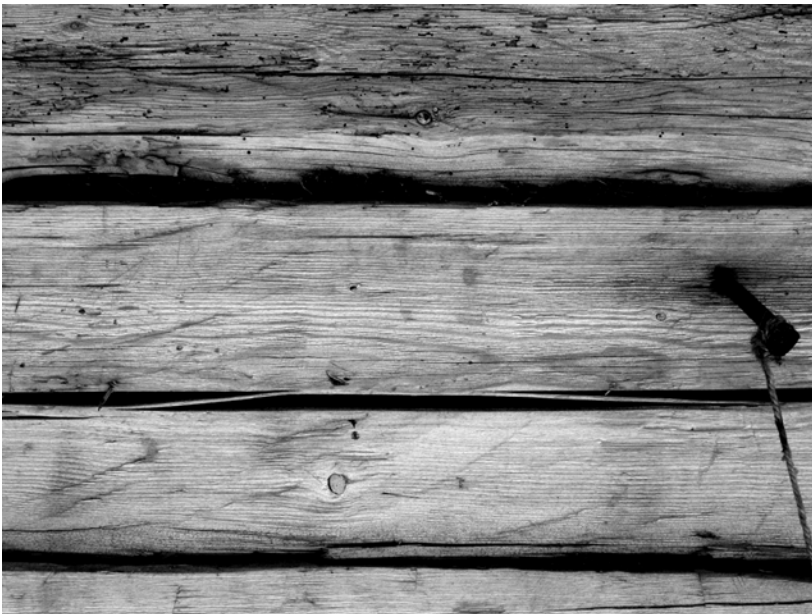
Foto 5.7.1.4.6. Sutlepa kabeli A sein. Vanema tahumise jäljed palgikidel A9, A10 ja A11.
