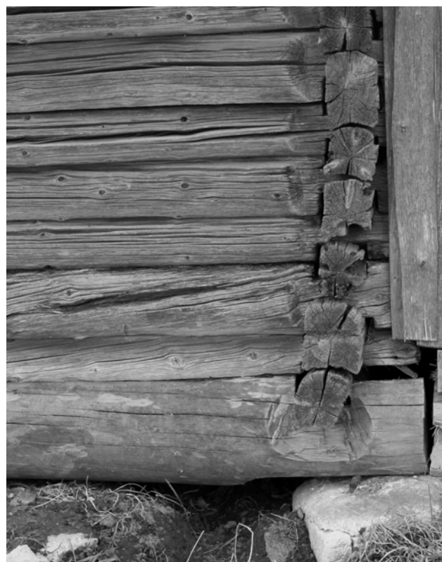
Foto 5.4.1. Palkhoone kahjustuste põhjustajad: 1. Inimtegevusetus, kliima ja elusloodus; 2. Seenkahjustus; 3. Putukakahjustus; 4. Füüsiline kahjustus; 5. UV-kiirgus, kliima, deformatsioon. Foto 4. allikas: Kilumets 2003
