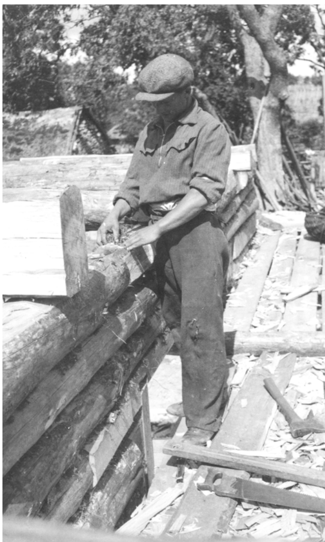
Foto 5.2.1. Uue palkehituse ehitusmees ja tolle tööriistad 1935. aastal. Käsisaag, lood, sirge varrega vene kirves. Fotol toimub hoone palkide vahe täitmine samblaga. Ümarpalkhoonel on ilmselt tappnurgad. Kailuka küla Vinni-Pärdi talu. Allikas: ERM fk 725 126
