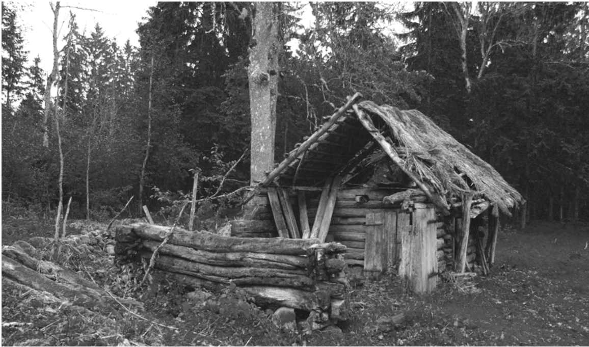
Foto 3.1.1. Sealaut Läänemaal. Vernakulaarse ehituspärandi hävinemine: tagasihoidlikud tingimused ja elukeskkond, distants suurematest keskustest, traditsiooniliste ehitusmaterjalide haprus, funktsiooni kadumine, hooletusse jätmine. Allikas: T. Suits
