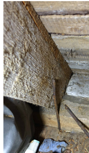
Illustratsioon nr 33. Räästasõlm. Sarikat, müürlatti ja karniisi ühendav sõlm. Näha on sarikale lisatud kiilukujuline klots ja ülemine karniisi kivi. Autori foto 22.04.2020
