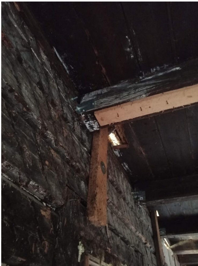
Foto 16 ülemisi palke ning laetala koos hoidvad metall ja puit-metall ühendused
