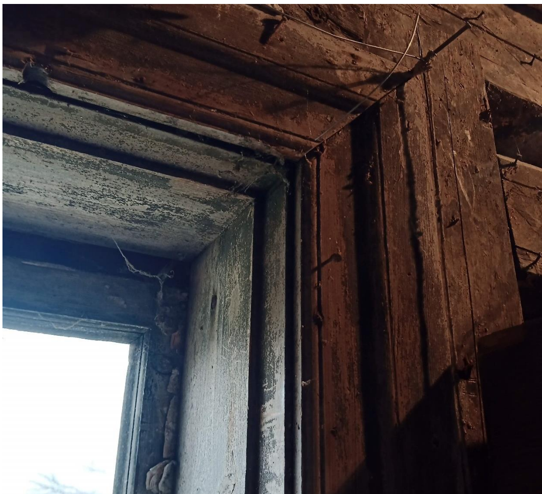
Foto 26 säilinud aknaleng koos piirdeliistuga
