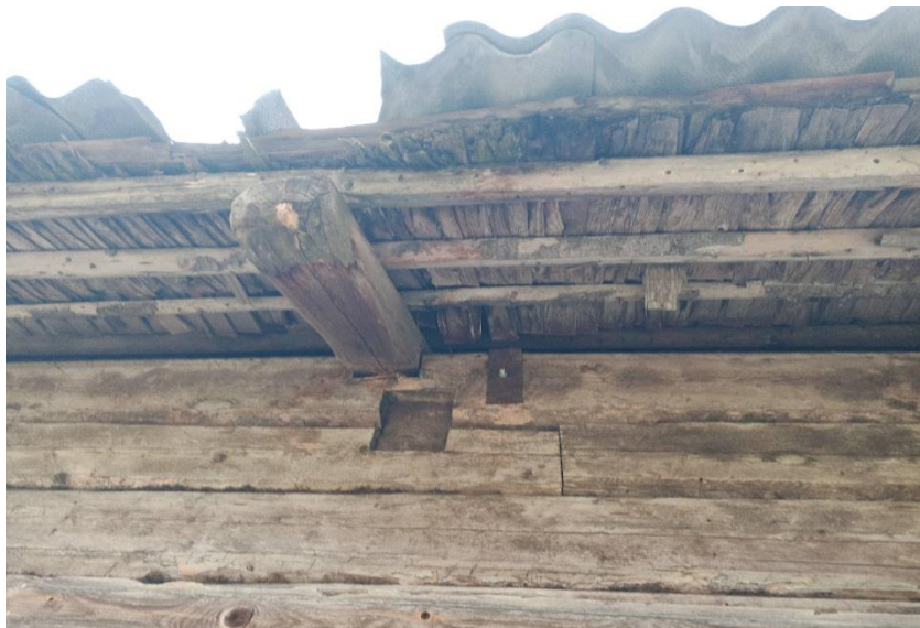
Foto 28 Murispuude väljavajumise peatamiseks mõeldud metallist liide
