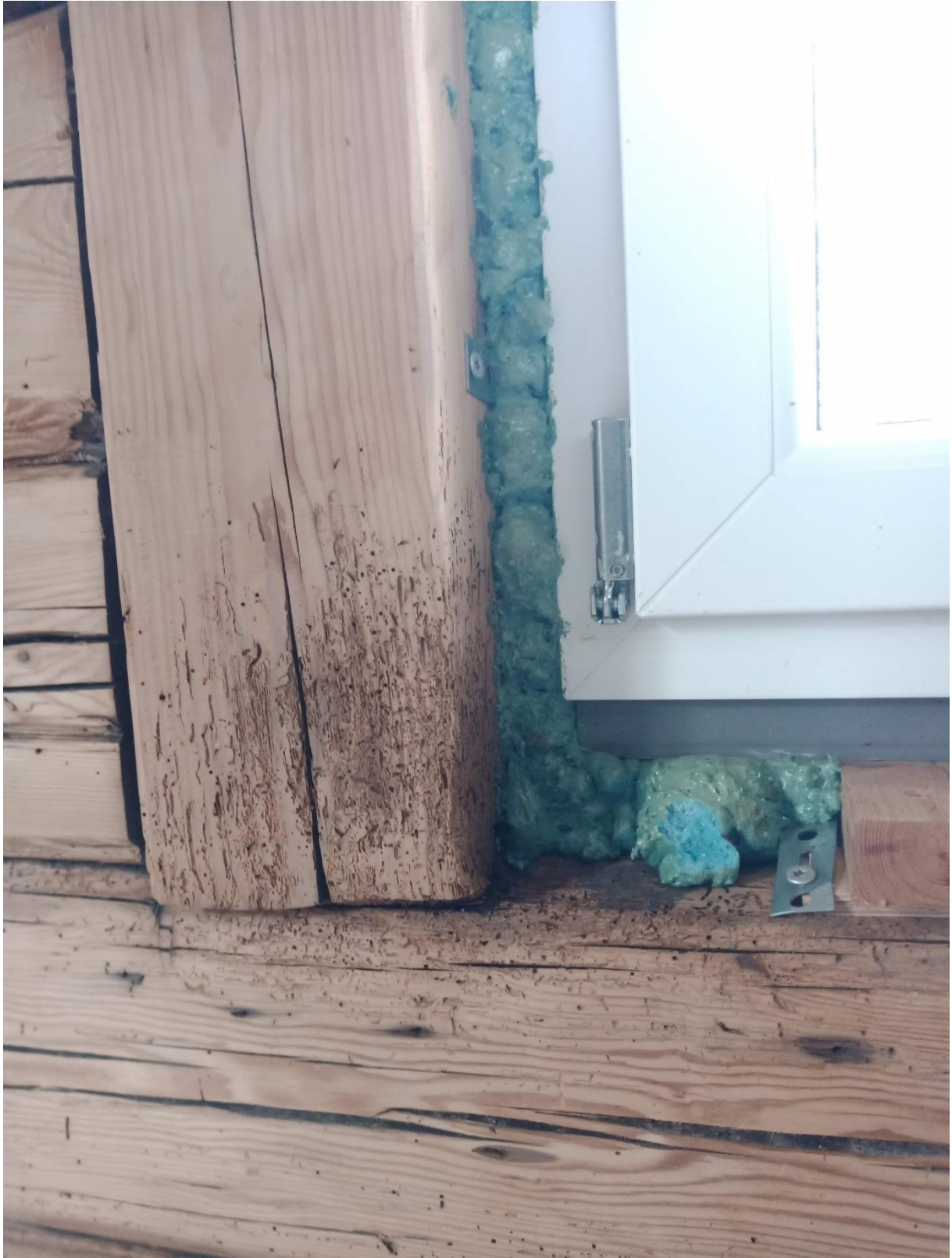
Foto 9 putukkahjuri tegevuse jäljed tenderposti alumisel otsal
