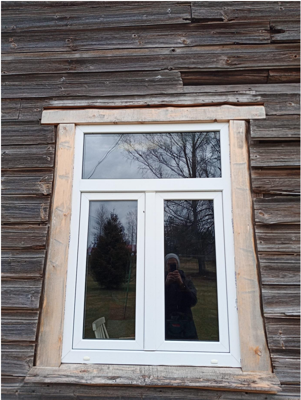
Foto 23 Ebaõnnestunud aknalahendus hoone edelaseinas
