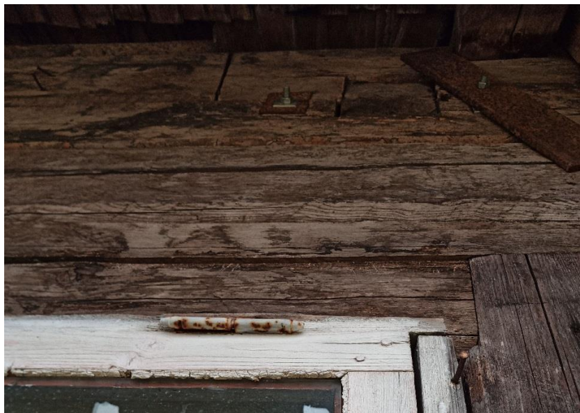
Foto 29 Näide käepärastest vahenditest valmistatud metall-liidetest
