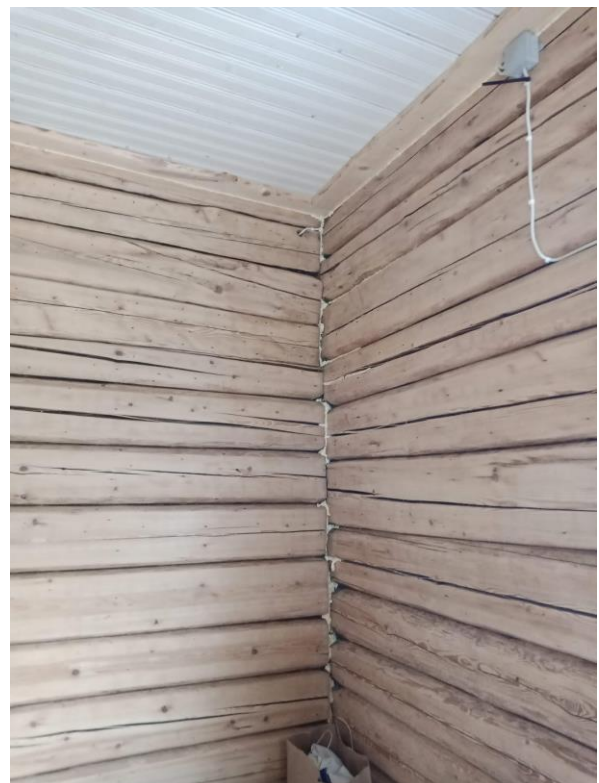
Foto 7 Montaaživahuga täidetud tapinurgad
