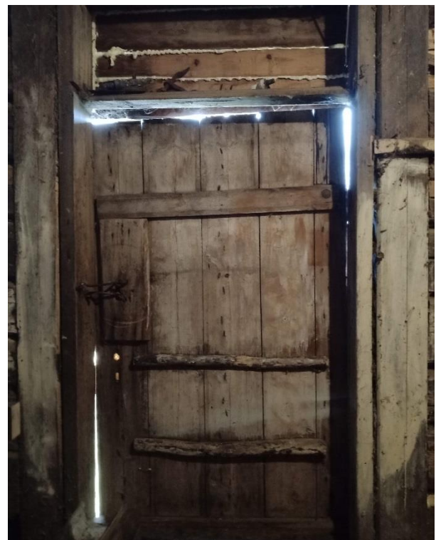
Foto 5 Sisevaade kooli kunagisele peasissepääsule
