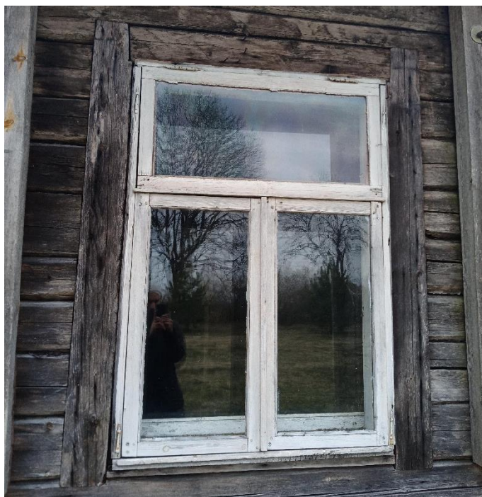
Foto 30 algupärane leng koos nõukogude aegse aknaga hoone loodeküljel
