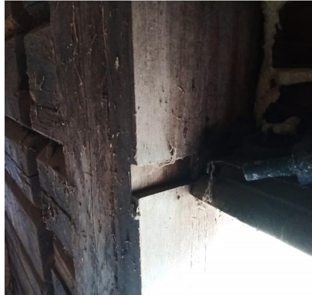
Foto 4 Rõhtimposti jaoks süvistatud pesa kirdeseinas paikneval ukselelil
