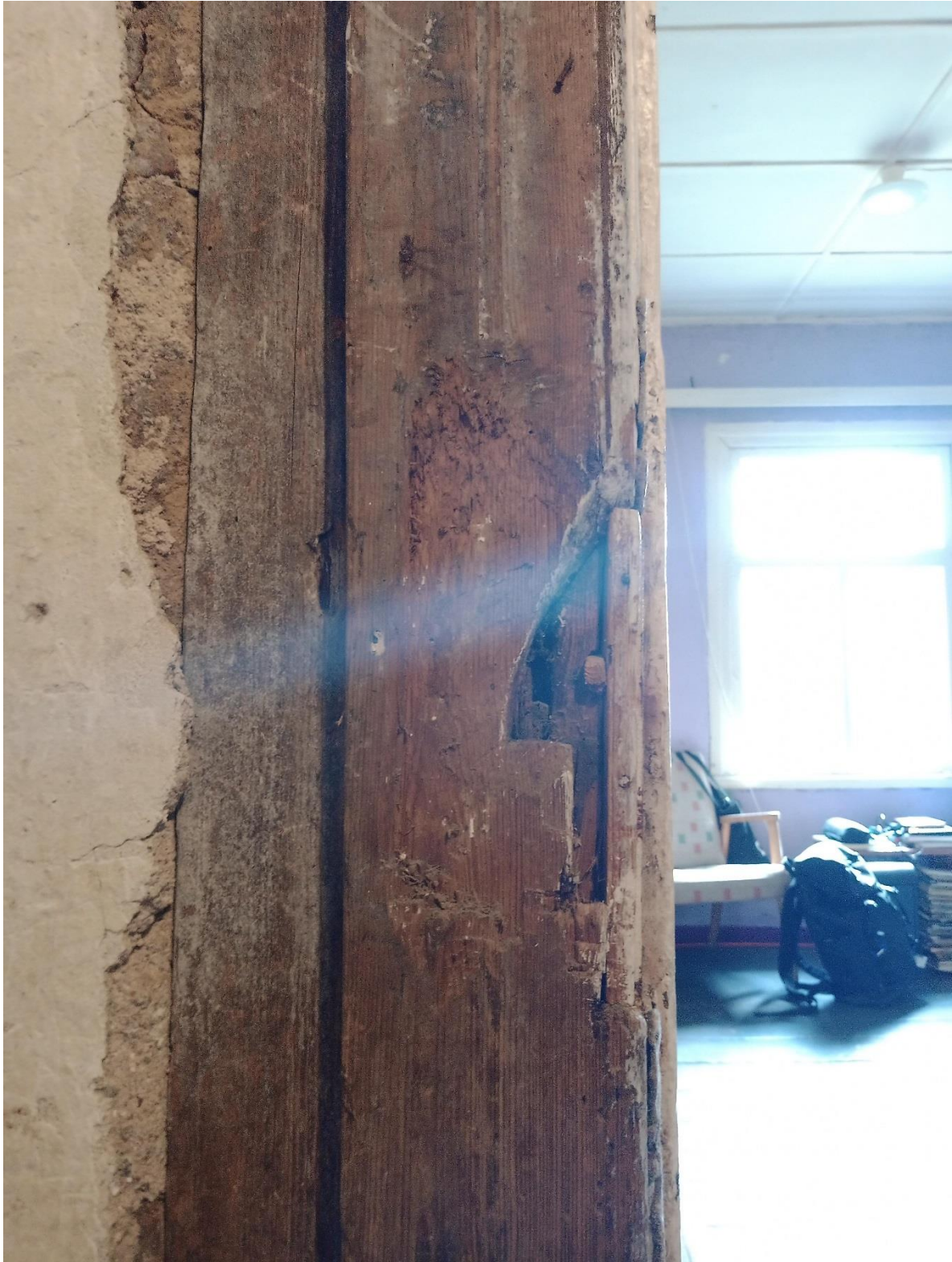
Foto 12 Vanast klassiruumist kööki suunduva ukse riivipesa
