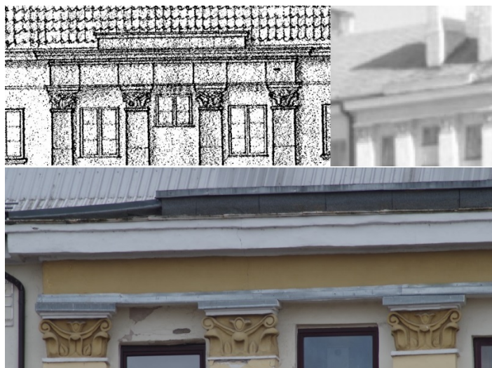
Jn 23. Peafassadi katuse karniisi ülemine osa. Projekti lahendus; seisukord 1950 aastal; tänane ilme. Skeemi allikad: Gradiens OÜ „Peetri plats 1,3 ja 5 hoonete fassaadide kordategemine. Fassaadide tehnilise seisukorra ekspertiis. Peetri plats 3., 2019. Narva; erakollektsioon; www.ra.ee/fotis/
