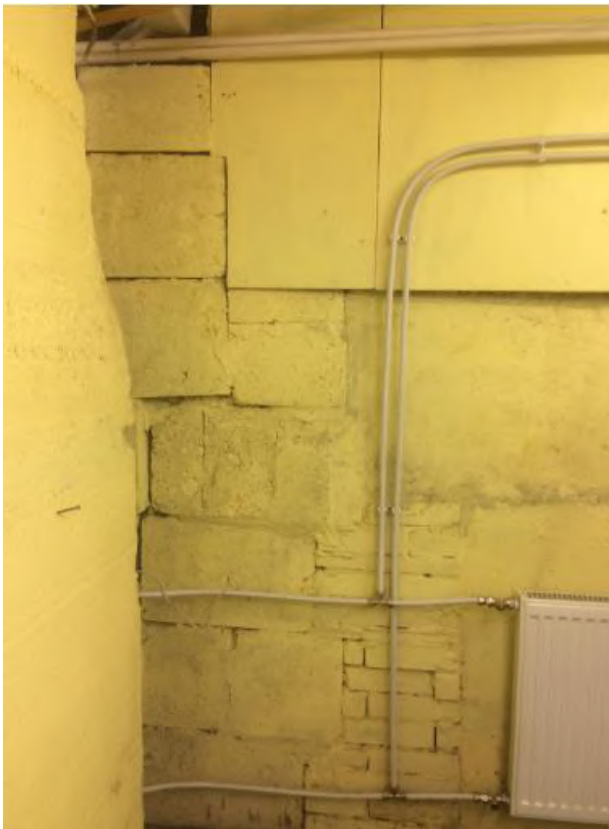
Foto: uue hoone aluse keldri seinte ladumisel on kasutatud käepäraseid ehitusmaterjale. Autori foto 20.02.2020
