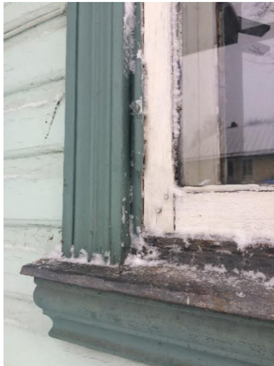
Foto, akna piirdelauad ja alumine aknakarniis on väga ilusa profiillõikega. Aknaplekk on heas olukorras, vajab värvimist. Autori foto 26.02.2020
