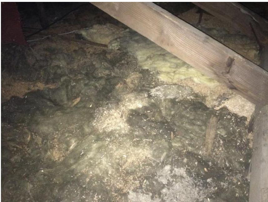
Foto, Saepuru ja selle peale laiguti pandud klaasvill. Autori foto 20.02.2020
