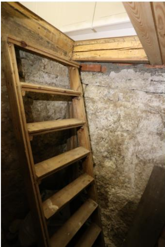
Foto: köögiälune kelder. Autor P. Pihlamäe 2019
