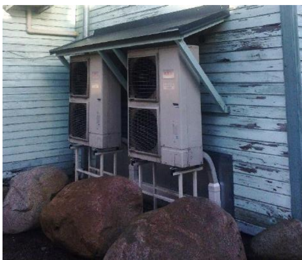
Fotod: Õhk-vesi kütte süsteem, vaade hoone loodenurgast ja vaade kütteruumis keldris Ruumides sees on vana keskkütte torustik ja malmradiaatorid. Autori foto 20.02.2020
