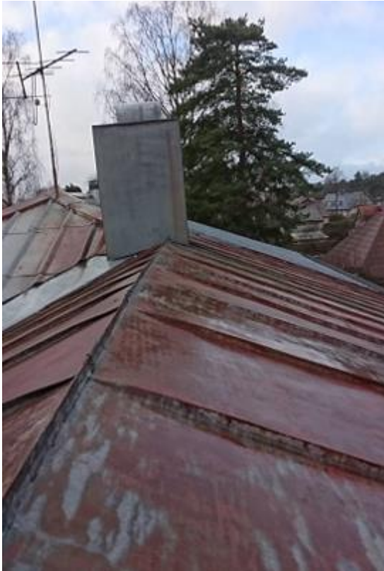
Foto, Katuse keskjoon ei jookse vanal ja uuel hoonel kokku , sest kesktelg hoonel on teine. Uus hoone teeb sammu väljapoole. Autori foto 20.02.2020
