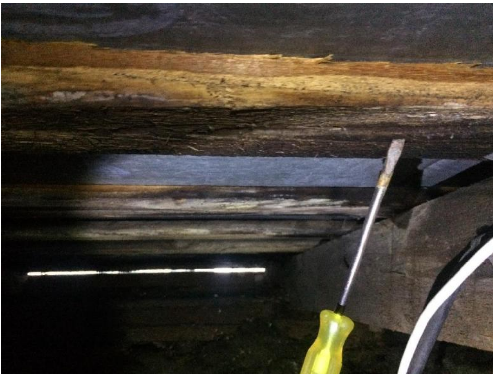
Foto, Roovituslaud on niiskuse tõttu pehkinud, näha on hallitust. Autori foto 20.02.2020
