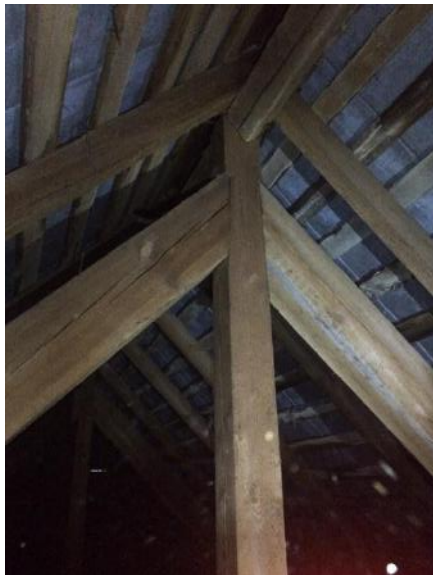
Foto, Palvela saali võlvlae pealne katusekonstruktsioon on tugev. Autori foto 20.02.2020
