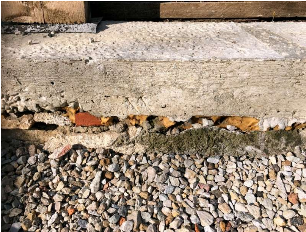
32. Uus vundament hoone idatiivale.
