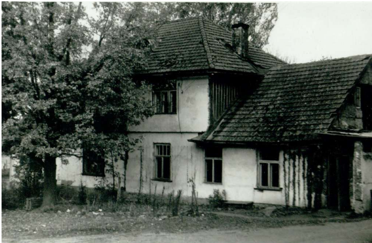
6. Vaade peahoonele lõunast 1976. okt. 12
