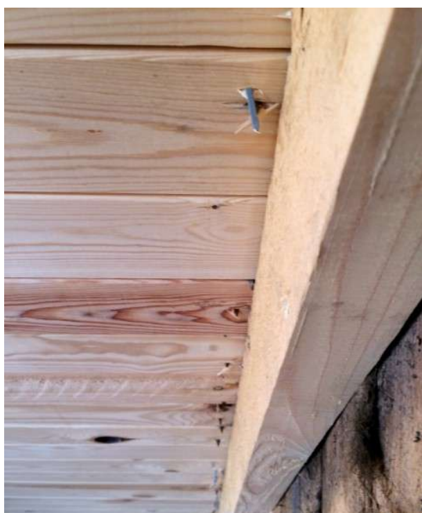
45. Ehitusviga uuel katusel, kogu naelterivi on sarikast mööda löödud.
