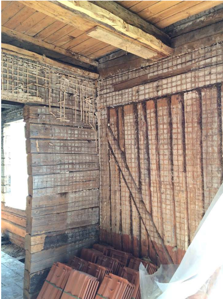
56. Puhtaks lammutatud palkseinad
