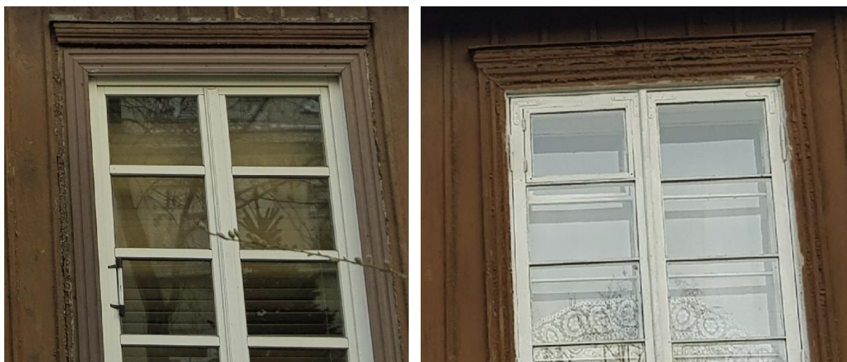
17. Vasakul välja vahetatud ja paremal originaalne piirdelaud.
