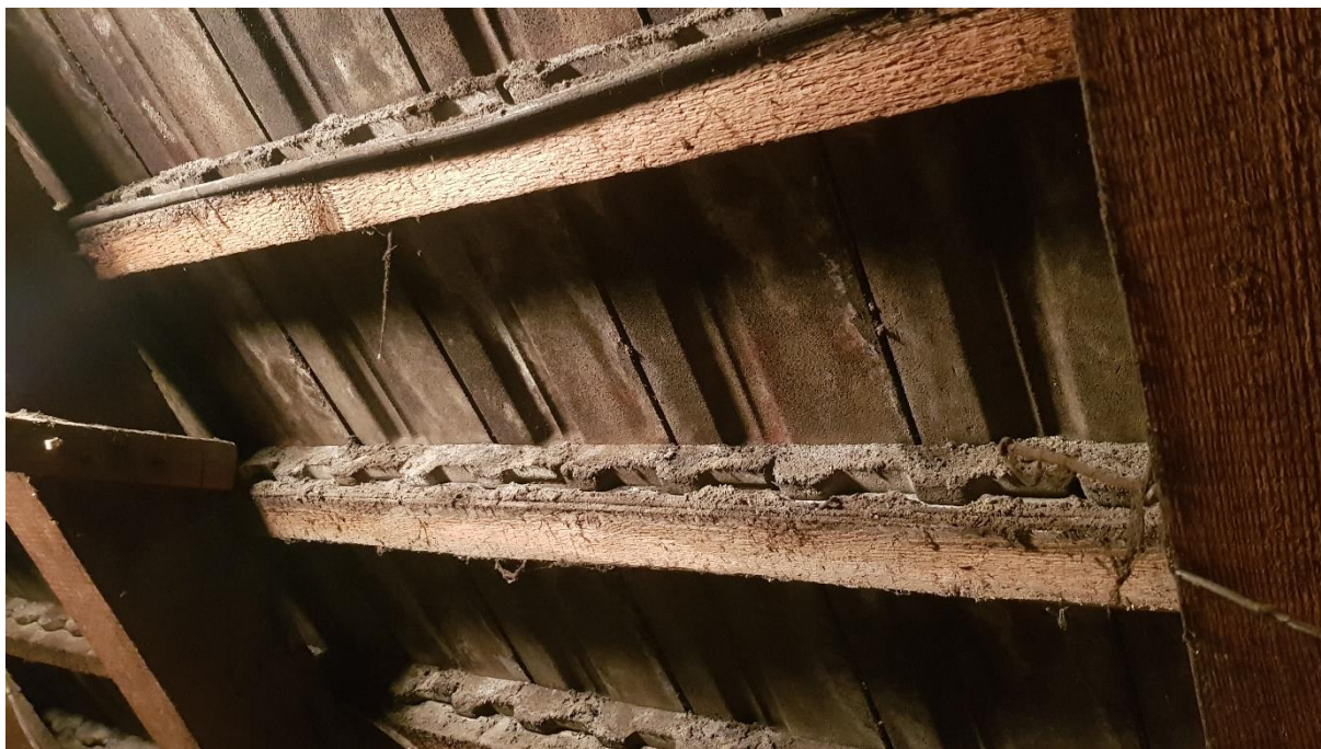
26. Vaade katusekattele pööningul.
