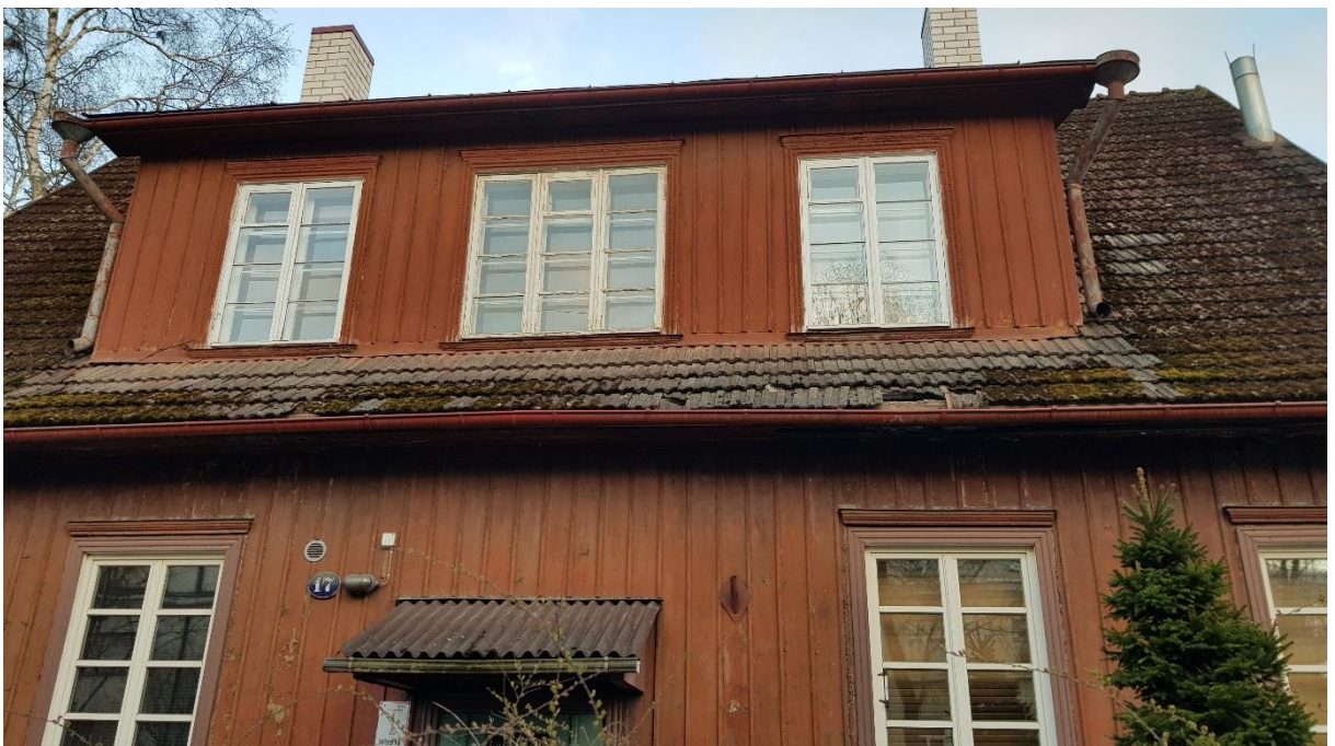
25. Vaade tänava suunast. Suurimad katusekahjustused asuvad räasta piirkonnas.
