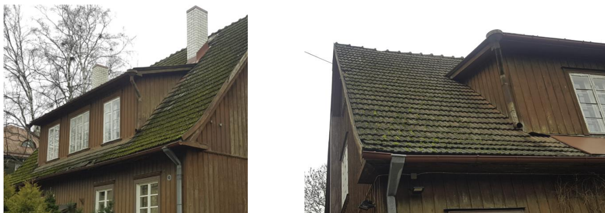
18. Vasakul sammaldunud valtskivikatus tänava pool ja paremal hoovi pool.
