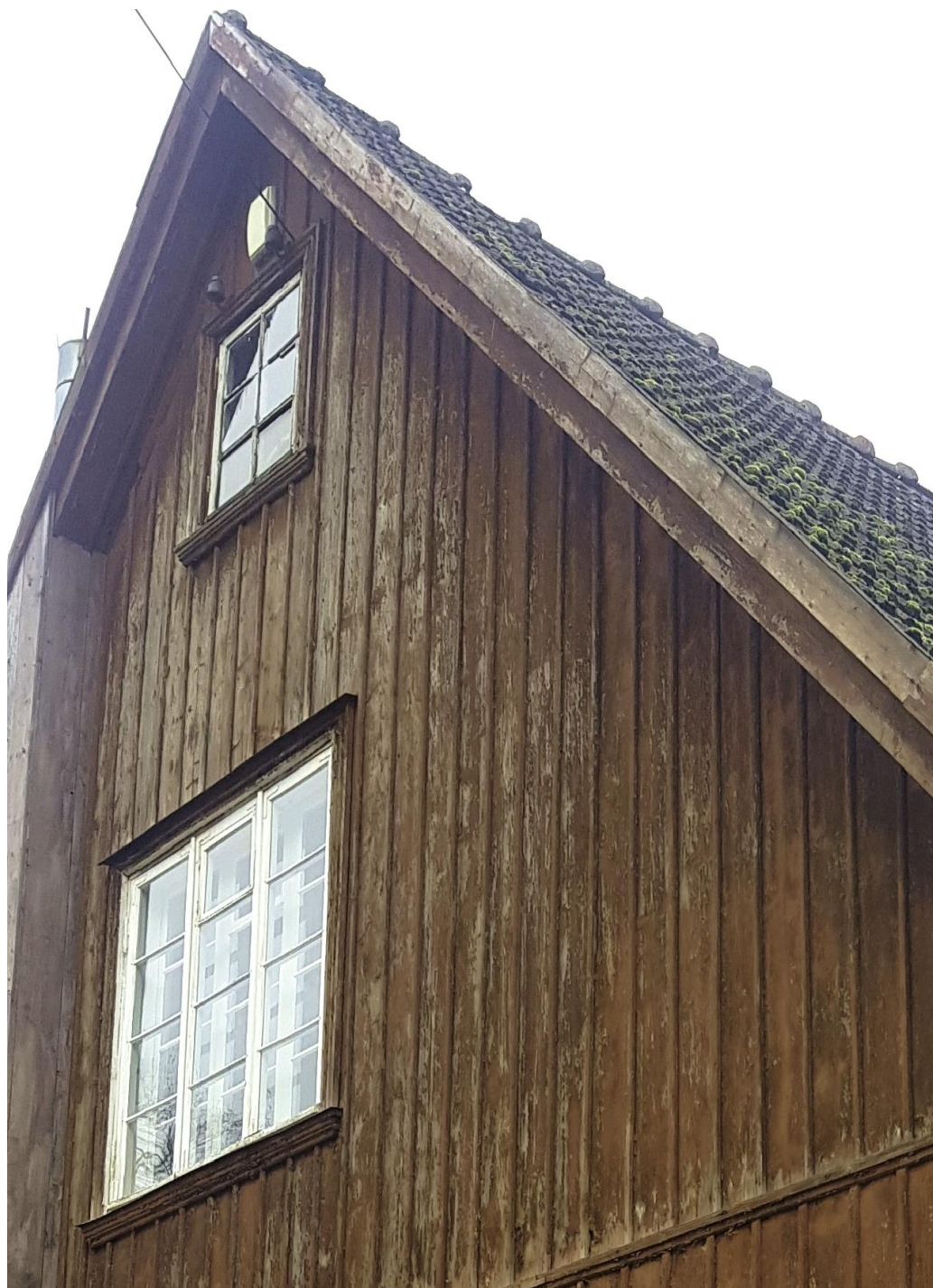
16. Teise korruse originaalaknad. Külma pööningu aken on üheraamne.
