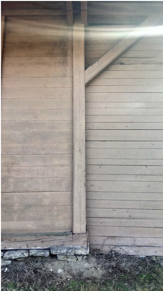
III 20. Tugipost, -käpp, alusraam ja sokkel
