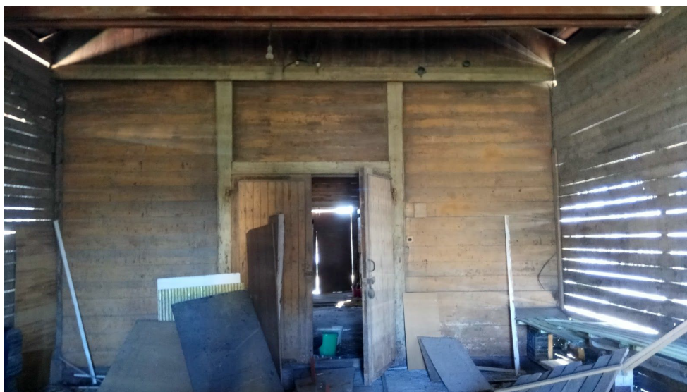
III 26. Algupärane läänepoolne sein originaaluksega.
