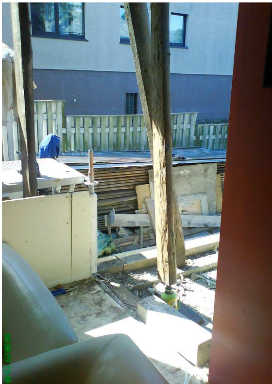
ill 65 Hoone tagasein on eemaldatud karkassipostide asendamiseks.
