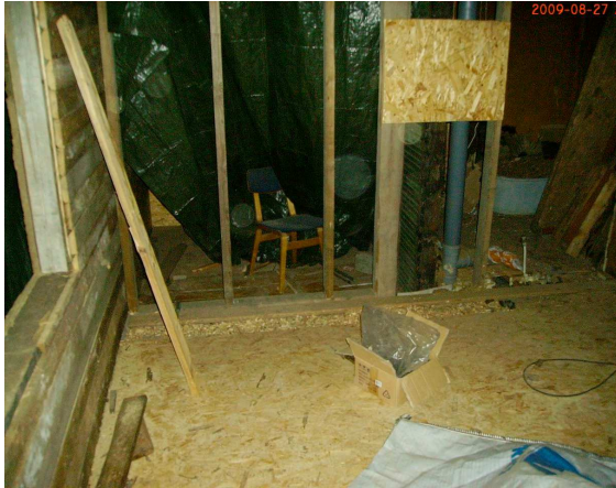
ill 75 Põrandakatteks 15mm OSB plaat, mille paigaldusel arvestatud laagi sammuga 30cm.
