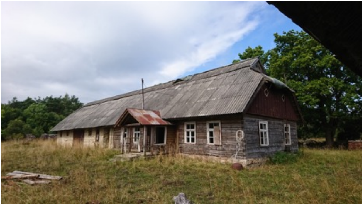
Illustratsioon 22 Rehiaju ja põrandaaluse küttesüsteemiga kooselamu, mille palkosa pakuti jaanuaris 2020 ära vedamiseks. Autori foto.
