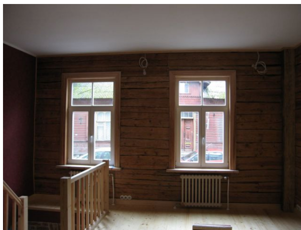
56. Sügise 14. I korruse korteris on osaliselt eksponeeritud palkseina. Trepp viis keldrikorruse puhkeruumi. Foto: A. Nool, september 2006.
