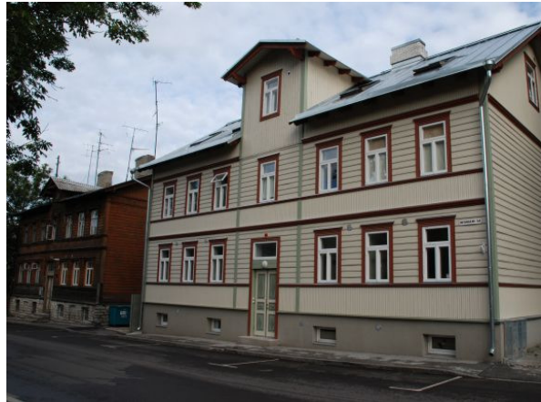
43. Wisamri 34. Tõstetud on nii harja kui räästast, frontoonist on saanud “kuldnokapuur”. Foto: I. Martin, august 2007.
