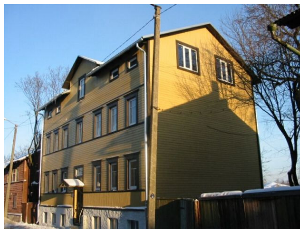
42. Kõie 16. 1m võrra on tõstetud nii räästast kui harja. Rek. pr. 2003, Casa Project OÜ. Foto: A. Nool, talv, 2004.
