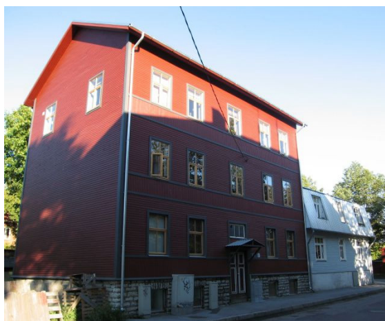
41. Õle 2/Telliskivi 29 põhimahule ehitati korrus peale ja madal maht sai “mätaskatuse”. Foto: A. Nool september 2006.
