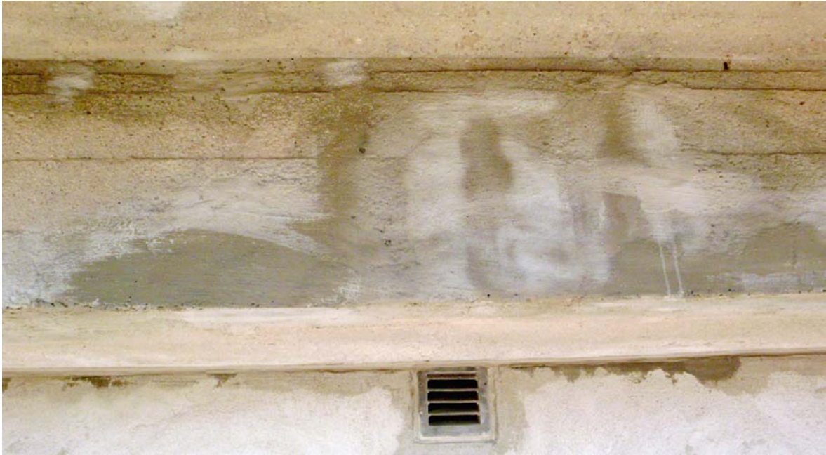
Foto 48 Betooni kohtparandused Kadrioru staadioni tribüünil Autori foto, 2009
