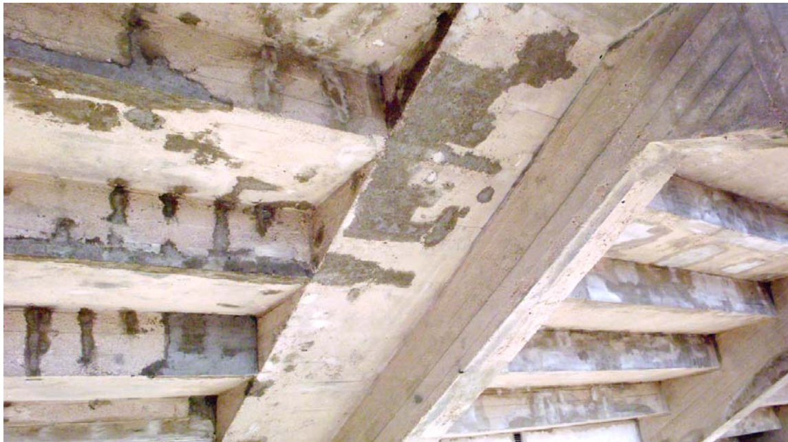
Foto 47 Betooni kohtparandused Kadrioru staadioni tribüünil Autori foto, 2009
