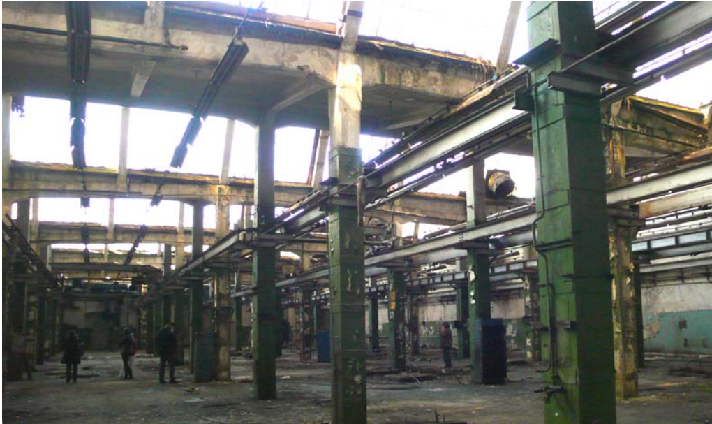
Foto 50 Dvigateli mehaanika-montaažitsehhi sisevaade, Autori foto, 2009
