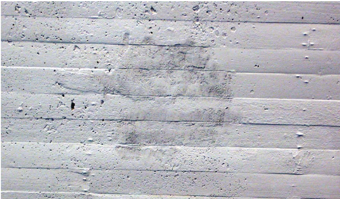
Foto 49 Betooni kohtparandused Kadrioru staadioni tribüünil Autori foto, 2009
