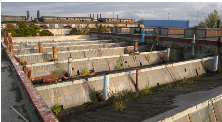
Foto 12 Vaade Dvigateli mehaanika-montaažitsehhi katusele Autori foto, 2007
