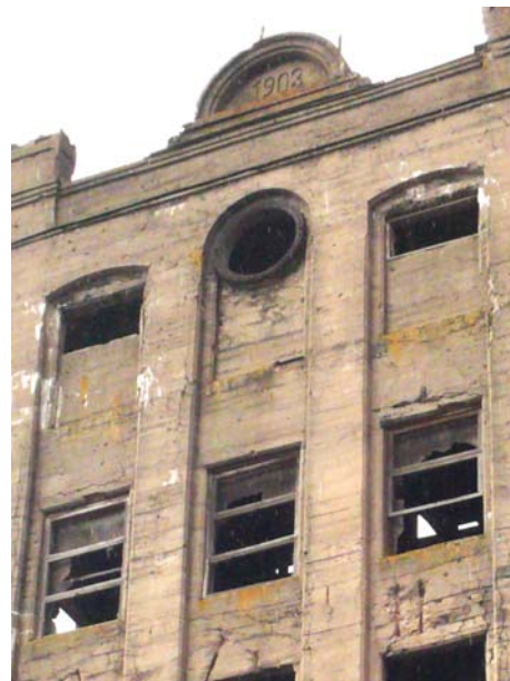
Foto 20 Sindi kalevivabriku kella- ja veetorn Autori foto, 2008
