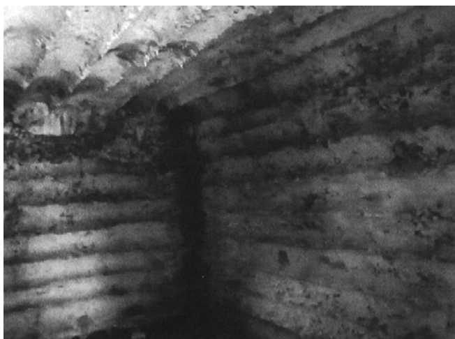
Foto 21 Ümarpalkidest raketise jäljed varjendi seinal Repro: Eensalu, M. Pihel, L. Peeter Suure Merekindlused Tallinnas. TKA n. 9, s. 1517
