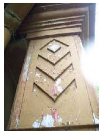
Joonis 4.47 Värvimäärangu koht, loodesuuna aknapiirdelaualt, autori foto.
