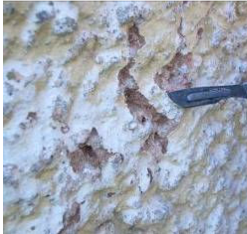
Joonis 4.52 Arvatav värvimulla kontsentratsioon krohvipinnas, autori foto.
