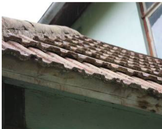
Joonis 4.167 Punaseks värvitud betoon katusekivi, aknaraami värvitud sevajoon, autori foto.
