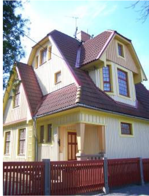
Joonis 2.21 Tartu, arh. A.Podčekajev Elva 3, pärast rekonstrueerimist, autori foto.
