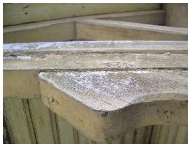
Joonis 4.147 Varikatuse (joonis 4.146) ehiskandur, autori foto.
