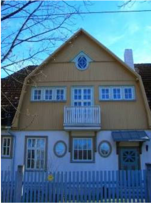
Joonis 3.10 Tartu, Elva 6, peale rekonstrueerimist. Arhitekt teadmata. Kas keegi on jäljendanud K.Burmanit ? Autori foto.
