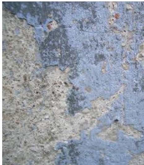
Joonis 4.152 Seinapinna fragment , keldri uksest paremal pool olevast soklipinnast, auori foto.
