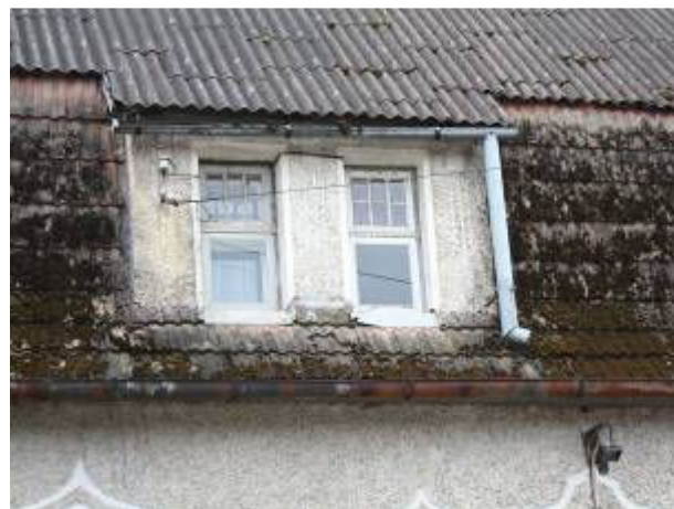
Joonis 4.163 Katuseuuk ja nähtav olemasolev ehitusaegne katusekivi, autori foto.
