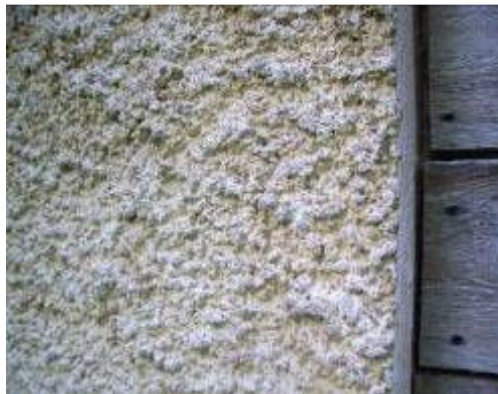
Joonis 4.52 Arvatav värvimulla kontsentratsioon krohvipinnas, autori foto.
