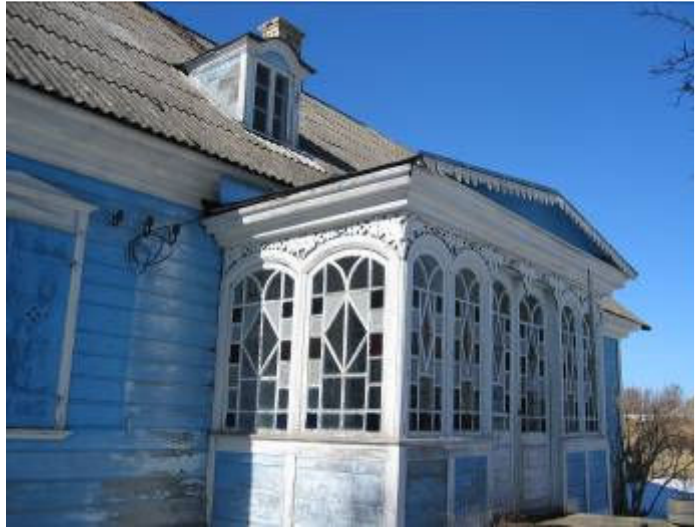
Joonis 3.2 Mereäärsusele viitab ka sinise ja valge värvi kombinatsioon, säilinud on värvilised ja jääklaasi mustri verandaklaasid, autori foto.
