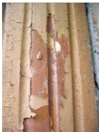
Joonis 4.46 Värvisondaaži koht uksest, autori foto.
