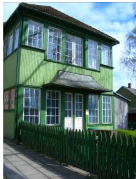
Joonis 4.134 Väljapääs aeda, uste kohal oleva varjualuse hiinapärane katus, autori foto.
