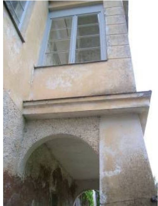
Joonis 4.28 Vaade ida pool asuvat verandat toetavale sambale ja dekoratiiv kaarele, autori foto.
