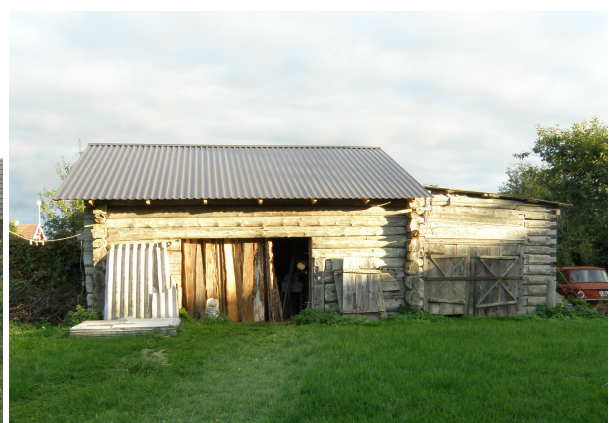
153. Vasakpoolsel fotol olev ait on hoolikalt restaureeritud. Lisaks uuele katusele on vahetatud ka otsaseina palke. Kuigi parempoolsel vanal rehel pole enam erilist otstarvet, on omanik võtnud vaevaks hoonele paigaldada katuse. Olgu või ajutine katus, aga hoone on selleks korraks päästetud.
