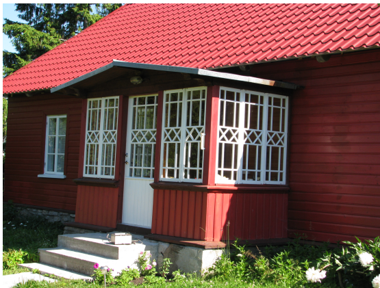
148. Rumpo Martise talu veranda aknad on vahetatud puitakende vastu ja hoone traditsiooniline ilme on säilinud.
