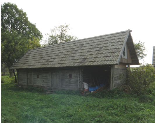
153. Vasakpoolsel fotol olev ait on hoolikalt restaureeritud. Lisaks uuele katusele on vahetatud ka otsaseina palke. Kuigi parempoolsel vanal rehel pole enam erilist otstarvet, on omanik võtnud vaevaks hoonele paigaldada katuse. Olgu või ajutine katus, aga hoone on selleks korraks päästetud.
