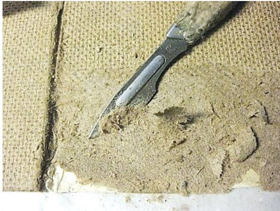
33./34. Masoniitplaadi õhendamine ja eemaldamine. (Autori fotod).
