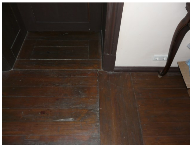
261. Ruum nr 1 põranda detailvaade.
