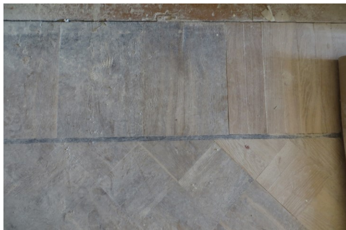
106. Detailvaade osaliselt restaureeritud parkettpõrandast. Foto: T. Tiidor
