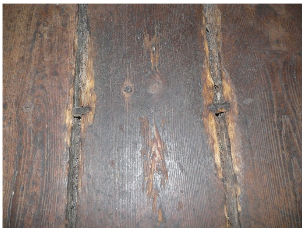
226. Söetunud põrandalauad Alatskivi mõisahoones.
