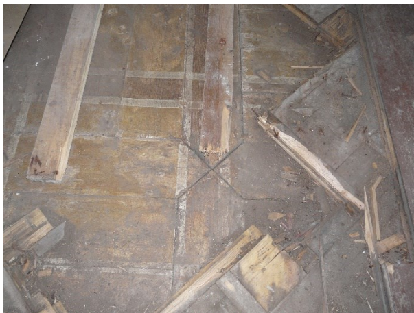
89. Detailvaade Härgla mõisahoones paiknevale laudpõrandale.
