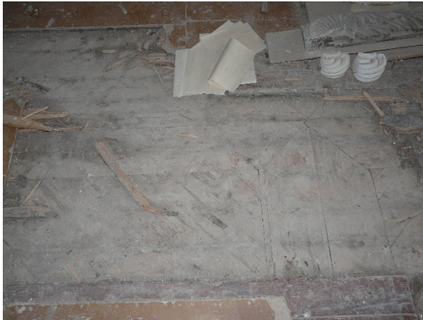
87. Detailvaade Kolga mõisahoones paiknevale laudpõrandale.
