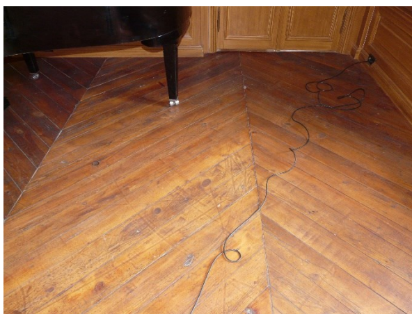
225. Klaveri liigutamisest tekkinud vaod Alatskivi mõisahoone saali laudpõrandal.
