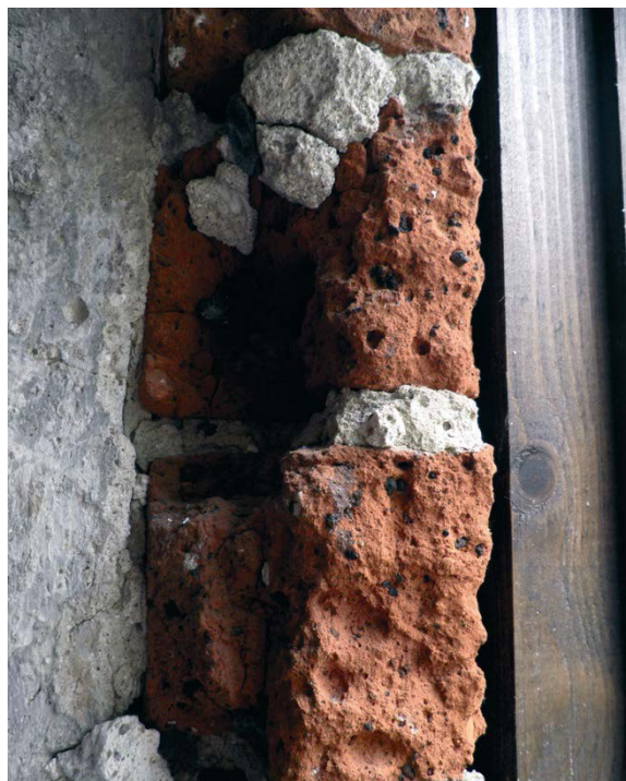
31. Tüüpiline tellisekahjustus Pöides. Pikihoone akna piit.
