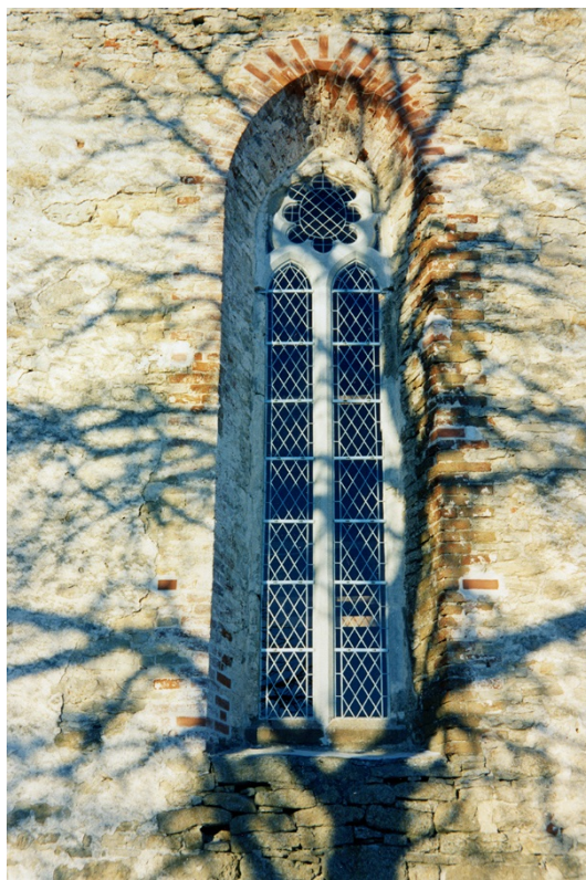
36. Koori idaaken pärast vitraažakna paigaldamist. Näha on uued asendustellised.
