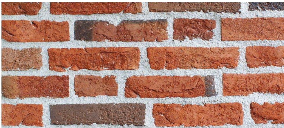
19. Tänapäevased „käsitsi“ valmistatud tellised. Pinna krobelisus saadakse savimassi manipuleerimisega, tavaliselt
