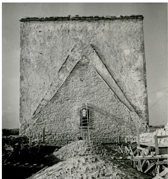
32. Viilude jäljed kiriku tornil. Ülemine on keskaegne.
