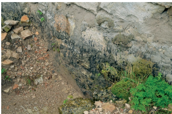
24. Põide kiriku bituumenist hüdroisolatsioon.
