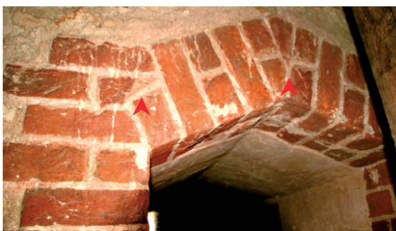
29. Tellisemaalingu fragmendid torni I korruse ukseava vormistavatel tellistel pikihoone poolsel küljel.
