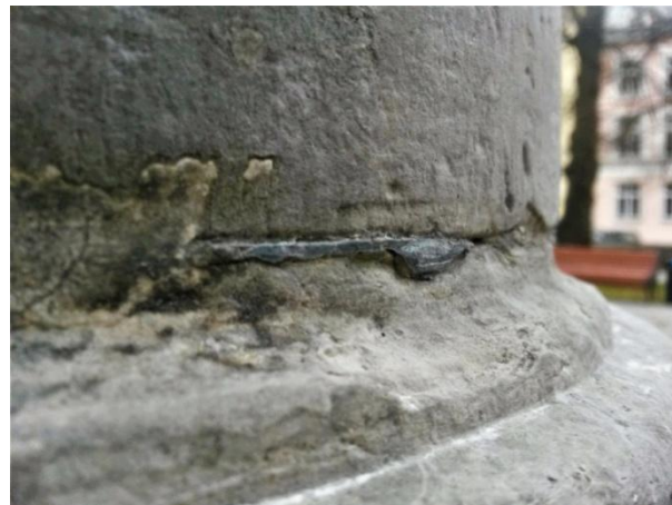
4. Sammaste püstitamisel kiviplokkide vahele pandud tinalaht. 05. VI 2016.
