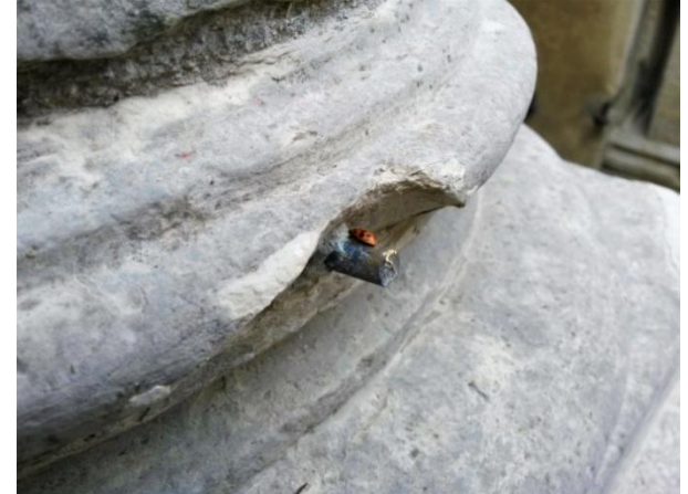
12. Eemaldatud varasema paranduse pronksist tüübel. 12. VII 2016.
