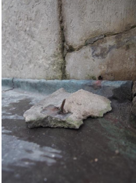
7. Metallist naelad, mille abil oli kinnitatud vaskplekkkatuse ääres olev mört. 15. IX 2016.
