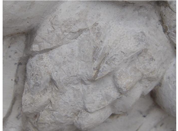
57. Avariiline irdunud pinnakiht stabiliseeritud. 29. IX 2016.
