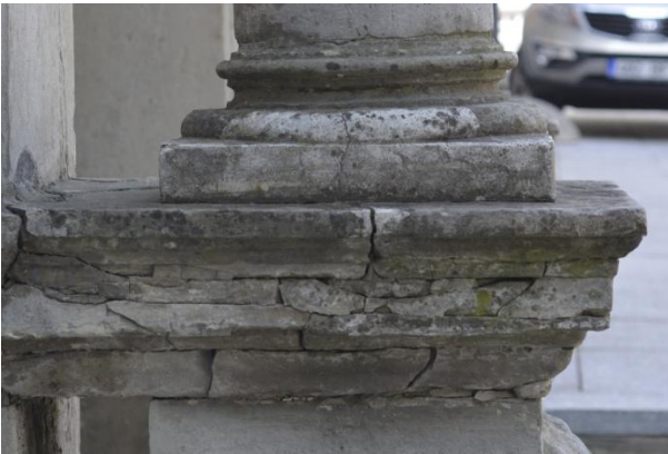
58. Idapoolse samba sügavalt lõhestunud baasi karniis enne konserveerimistööd. 10. V 2015.
