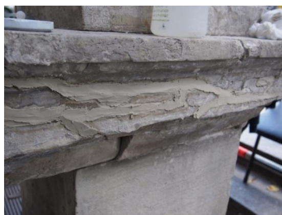
33. Praod täidetud peenmördiga. Üle äärte ulatub mört eemaldatakse hiljem. 12. IX 2016.
