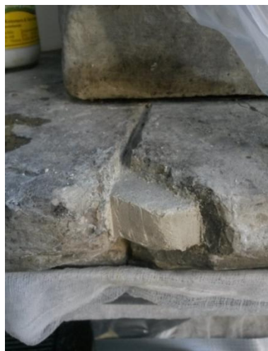
34. Esimene jäme mördikiht. 05. IX 2016.
