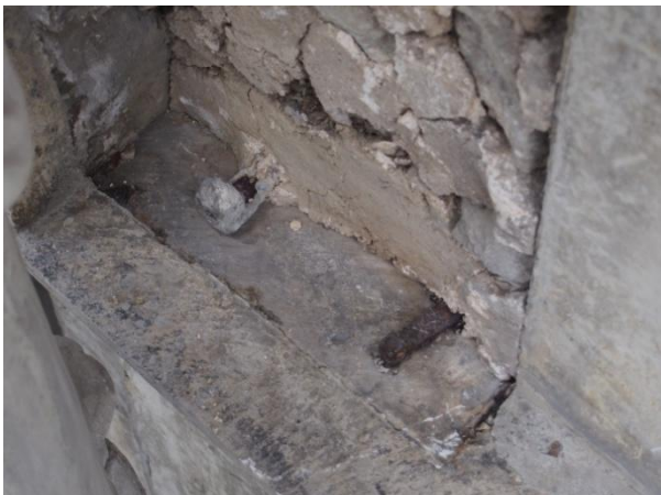
9. Läänepoolse samba tagant eemaldatud plaadi kinnitamiseks ettenähtud sepsirauast konksud. 27. IX 2016.
