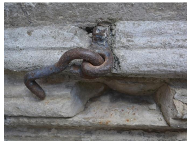
6. Endise ukse kinnitamiseks ettenähtud konksud. 05. VI 2015.
