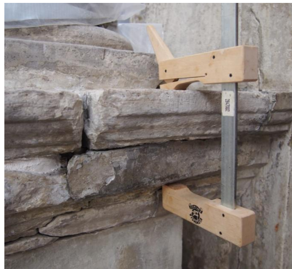
31. Sama paranduse kinnitamine uute vasest tüüblite ja epoksiidliimi abil. 01. IX 2016.
