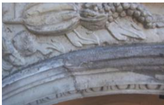
34. Jäme tsementmördiparandus portaali kaarel. 15 IX 2016.
