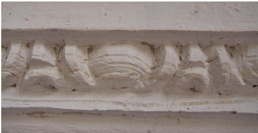
17. Pinnaerosioon tekstitahvli kohal oleva munavöödiga ehisliistul. 20. IX 2016.
