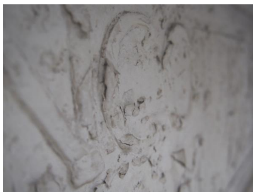
24. Irdunud pindmised kivikihid tekstitahvil. 15. IX 2016.
