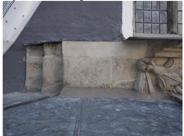
55. Paljastunud paekiviplaadid kaetud krohviga. 29. IX 2016.
