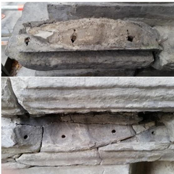
30. Eemaldatud tsementparandus ebaharilike puidust tüüblitega. Tegemist oli 1970. aastate konserveerimistödele eelnenud parandustööde käigus teostatud parandusega. 01. IX 2016.
