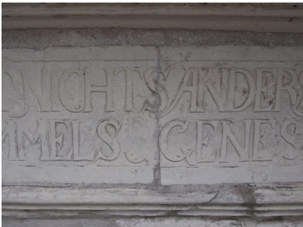
48. Sobimatut tooni tsementmördiga täidetud vuuk tekstitahvli plaatide vahel. 14. IX 2016.
