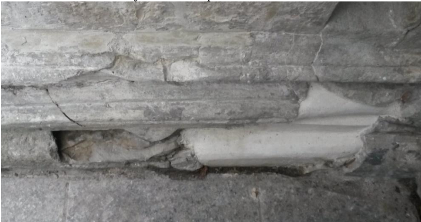
53. Materjalikadu pooleldi täidetud esimese jämedama mördikihiga. 10. X 2016.
