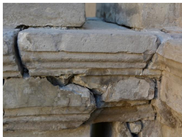
23. Lagunev mördiparandus, millel on näha niiskuskahjustusi- tumenenud mikropragusid. 01. IX 2014.
