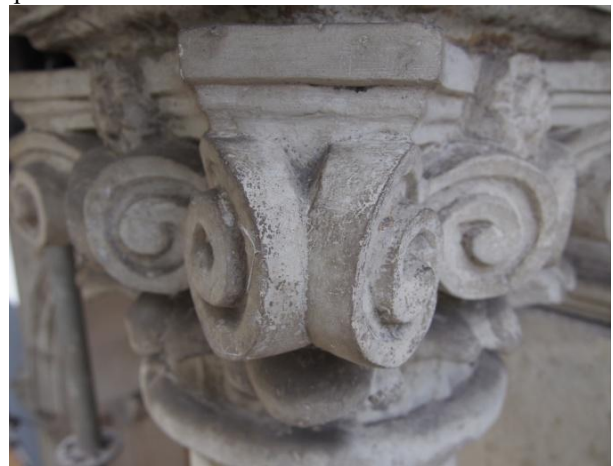
16. Tumenenud kiht samba kapiteelidel, mida märgpuhastuse abil ei olnud võimalik eemaldada. 23. IX 2016.
