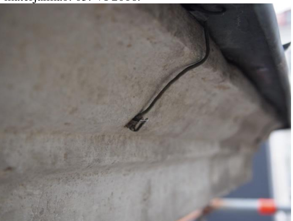
5. Vaskplekkkatus on kinnitatud samba kapiteelile puidust naelte ja traadi abil. 15. IX 2016.
