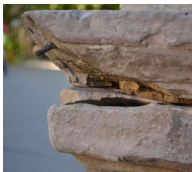
47. Lagunenud mördi eemaldamisel paljastunud pronksist tööbel. 20. VIII 2016.
