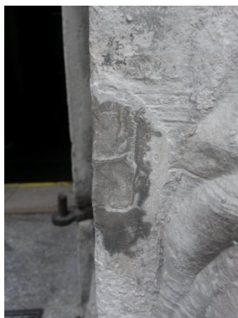
38. Tumenenud pinnaga mastiksmördiparandus. 15. VII 2016.
