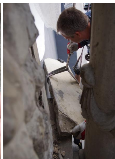
56. Välja vajunud plaadi eemaldamine. 24. IX 2016.
