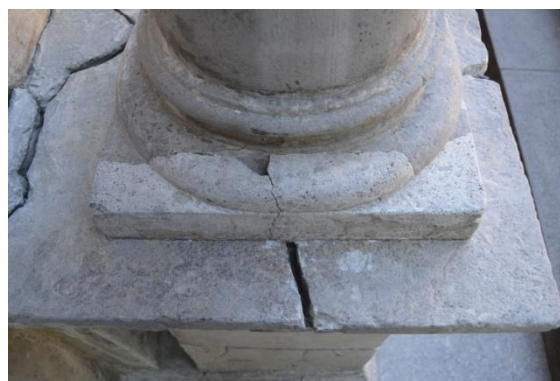
37. Lagunev valge tsemendi ja vesiklaasiga mört. 15. VIII 2016.
