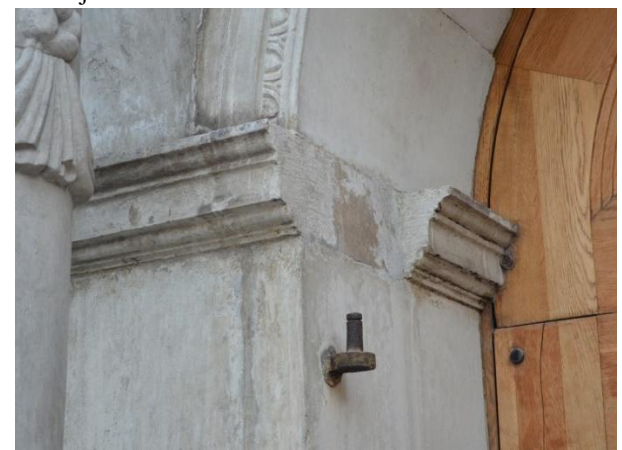
8. Endise ukse hing, mis on korrodeerumisest põhjustatud paisumisega viinud seda ümbritsenud materjali eemaldumiseni. 20. X 2016.
