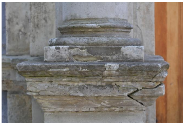
20. Samba baasi määrdunud karniis. Heledamad osad on vesiklaasi sisaldavad mördiparandused. 5. X 2014.
