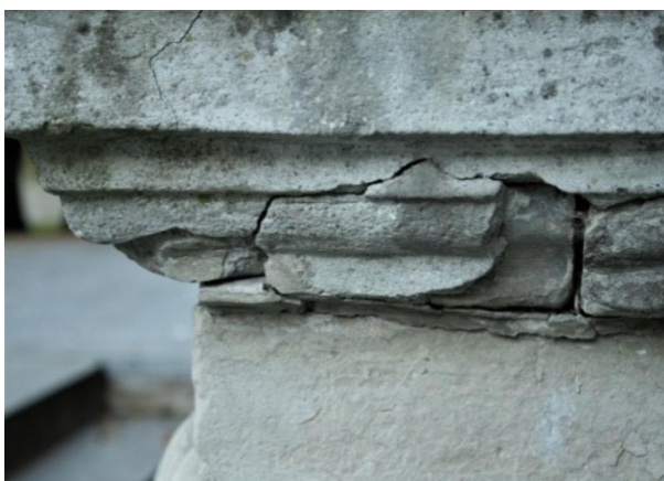
22. Lagunev mördiparandus läänepoolsel samba baasil, mille alt paljastub mördiga kaetud kivi originaalpind. 01. IX 2014.
