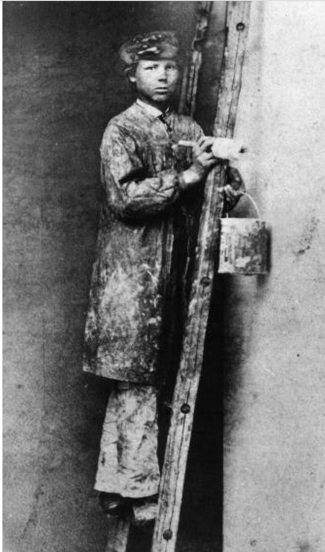
34. Õpipois isetehtud pintsli ja plekksepa valmistatud värvinõuga 1860ndatel aastatel seinä värvimas. Väljavõte raamatust „S. Wuorio, helsinkiläinen koristemaalausliike“.
