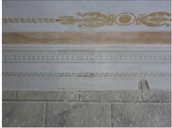
63. Aruküla mõisa peahoone teise korruse laemaalingu peegelvõlvi muster on tehtud trafarett-tehnikas, 19. sajand.
