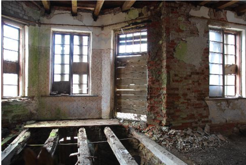
Foto 120. Põrandatalad ruumi 25 lõunapoolses osas.
