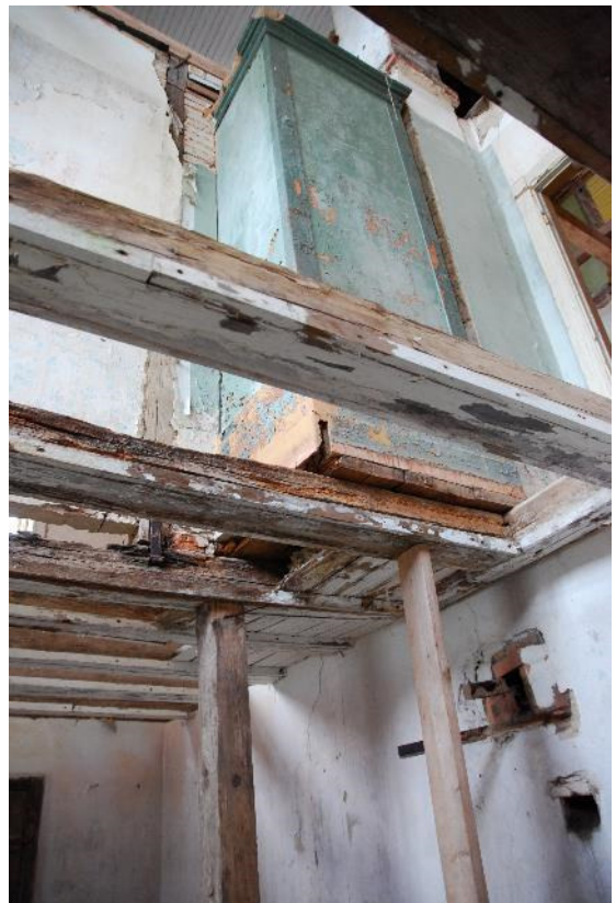
Foto 99. Ruumide 4 ja 5 kohal toetub ahi põrandalaudadele ja vajab lisatoestust.
