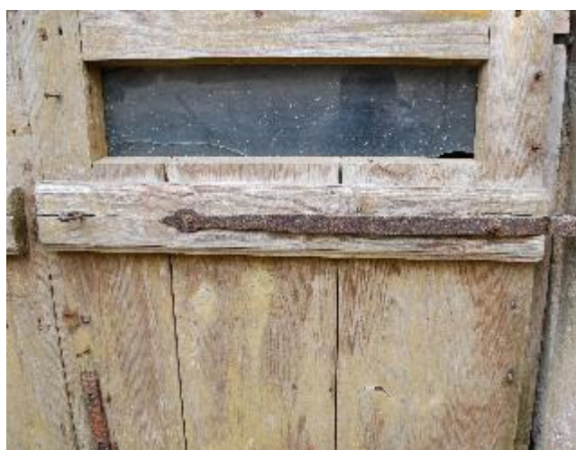
Foto 40. VU3 sepistatud uksehing.
