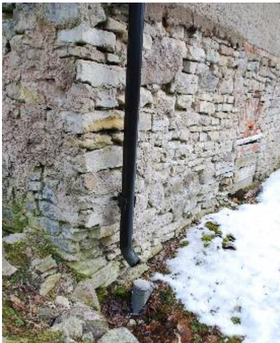
Foto 27. Sokkel hoone loodenurgas.
