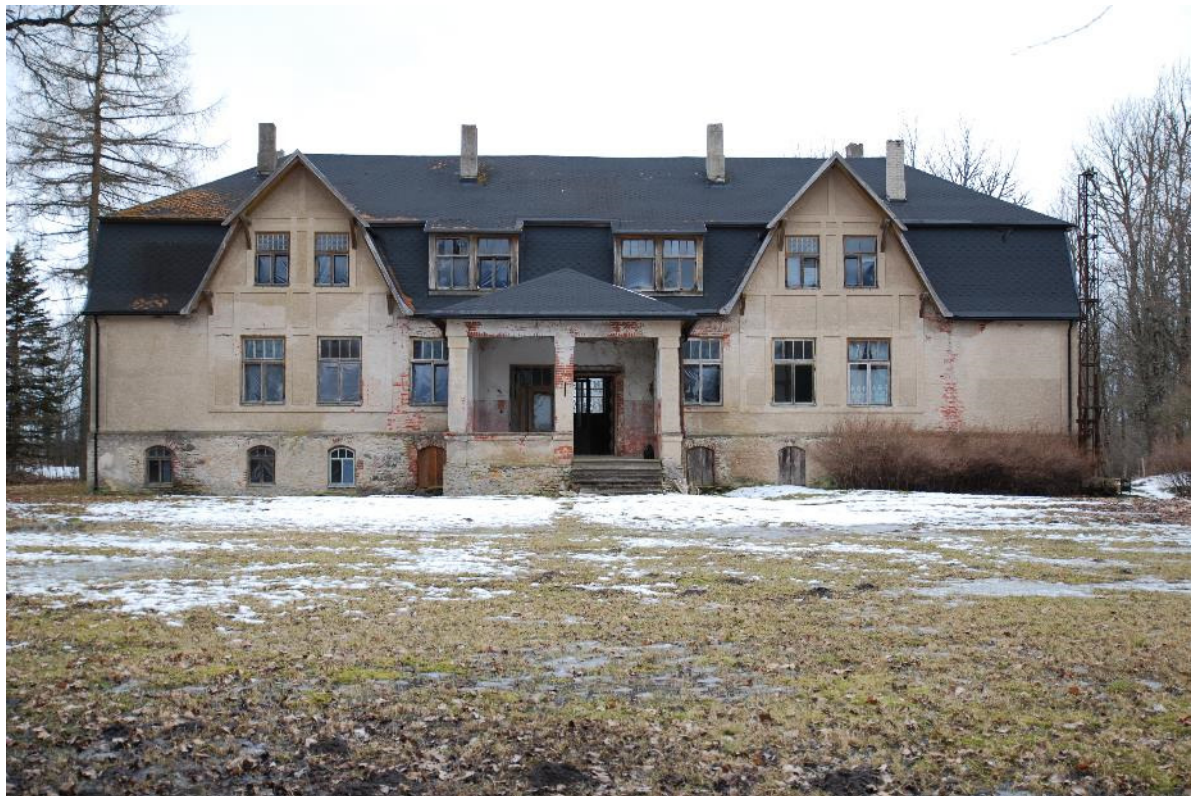
Foto 12. Roodi mõisa peahoone esifassaad, vaade idast.
