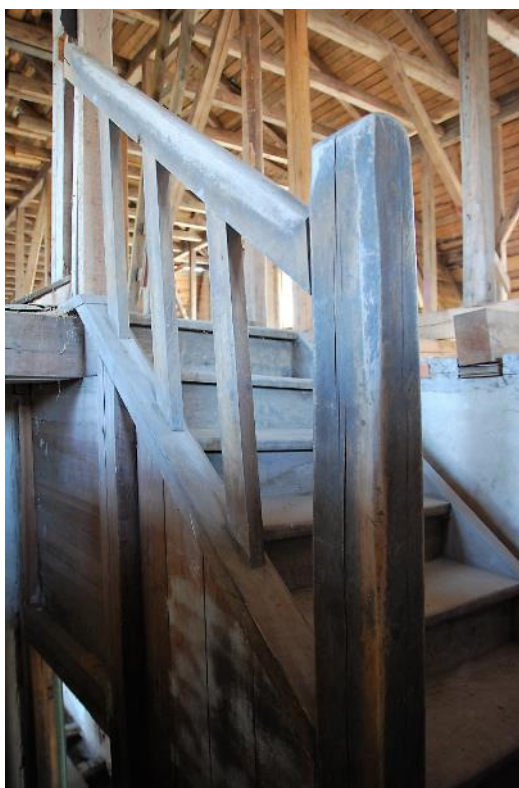
Foto 143. Mansardkorruse trepi piire.
