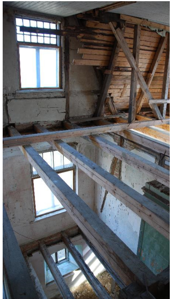
Foto 91. Vahelagedeta ruumide vaade läbi kolme korruse hoone idaküljes.
