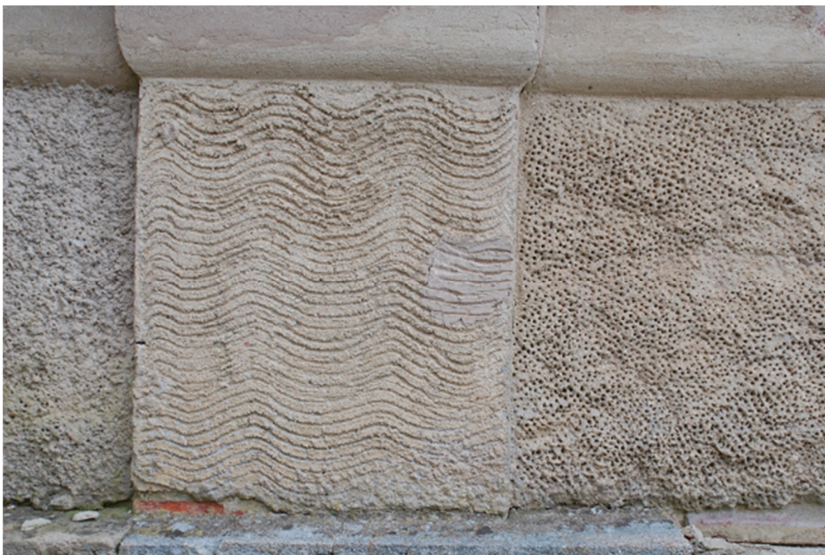
Foto 36. Fassaadi krohvimustri fragment veranda seinal
