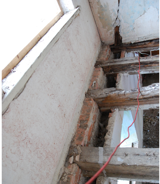
Foto 102. Tellissein paekivimüüri ees ruumis 5 (pildistatud ruumist 20).
