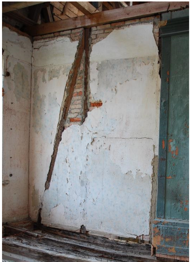
Foto 104. Siseseina konstruktsioon ruumis 20.
