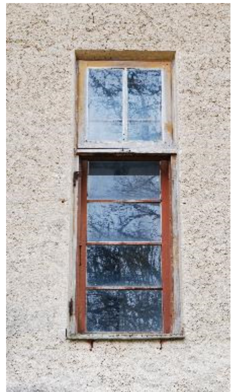
Foto 48. A3 väljast, sisemine raam ei ole algupärane.
