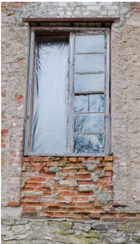
Foto 57. A4 aknaks ümber ehitatud ukseava.
