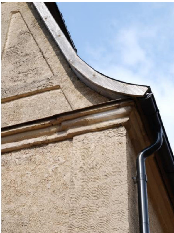
Foto 34. Karniis otsafassaadi poolviilu all ja esifassaadil.
