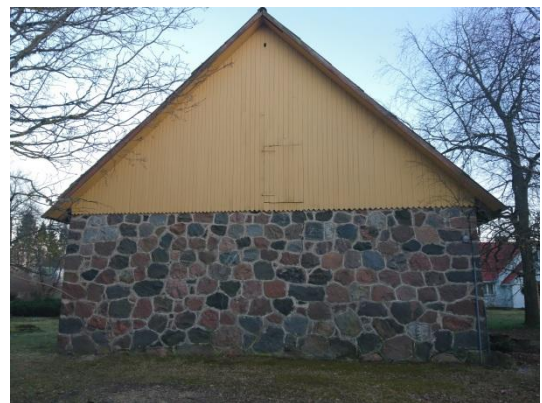
Foto 25 N Vaade põhjast
