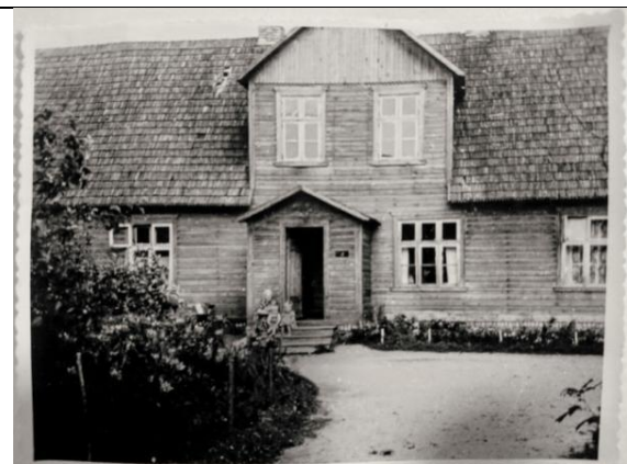
Foto 15 Algne katusematerjal oli puitsindel. Fassaad on kaetud profiil kattelauga. 1952 .
