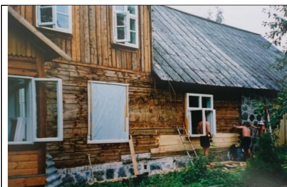
Foto 16 O Rõhtpalkseinad ja püstpalkseinad Rehetoa aknaaluse palgi vahetus 2003
