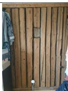
Foto 17 II korrusel on kasutatud vana elumaja palke Kogu perimeetril. Rehekast ja vaheseina
