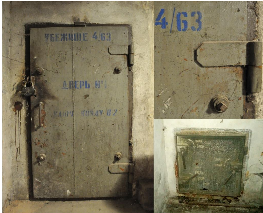
24. Varjendi uks šabloonkirjadega ja uksehinge detail. Varjendi väljumisluk kolme avamispööraga.
