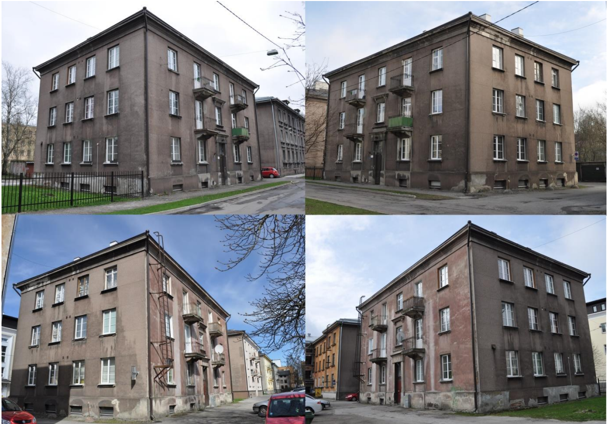
17. Vaated fassaadidele. Tänavapoolsed ja otsaseinad on viimistletud terrassiitkrohviga, hoovipoolne sein lubikrohviga.
