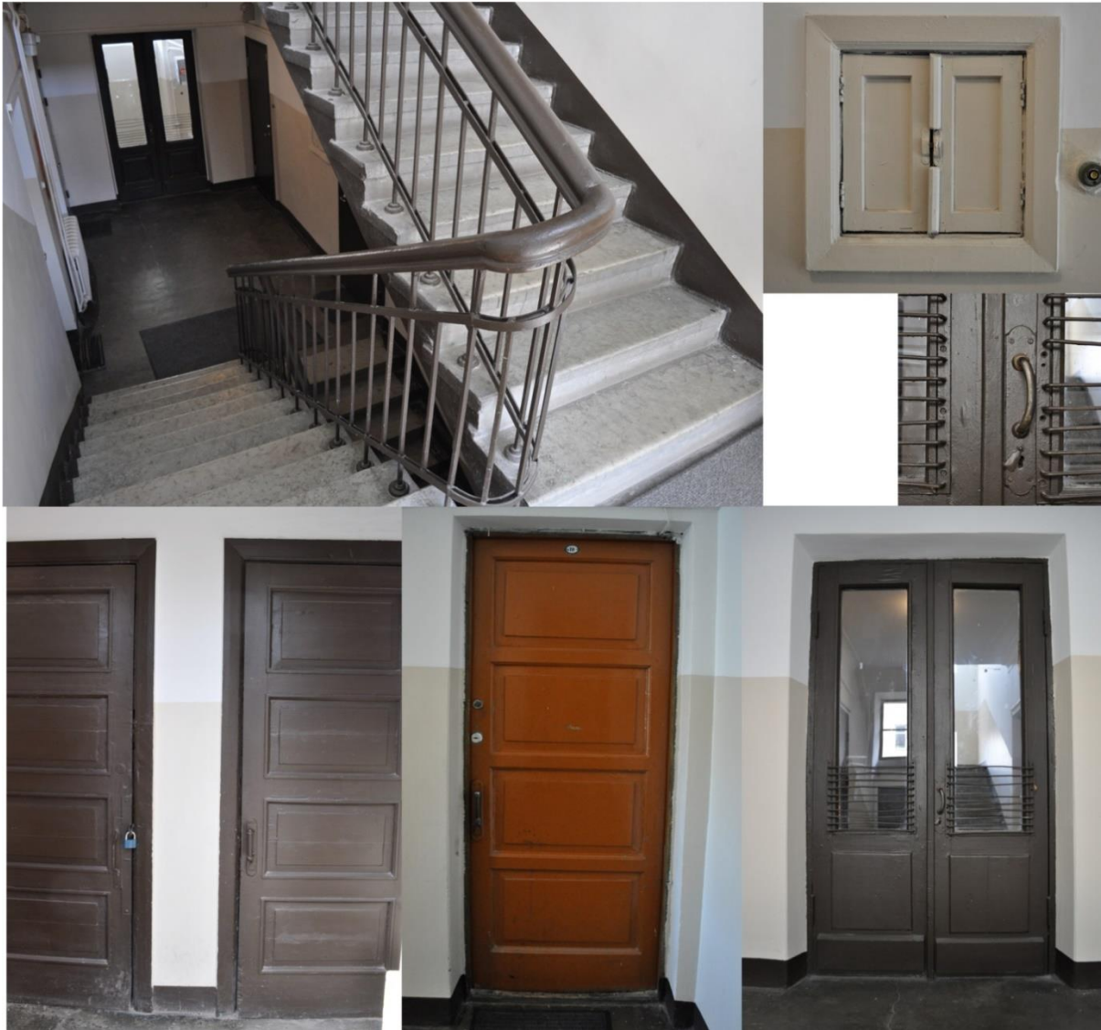
23. Väärtuslikud originaaldetailid trepikojas – trepipiire ja paekivist trepiastmed, elektrikappide uksed, trepikoja- ja korterite välisuksed, uste käepidemed.
