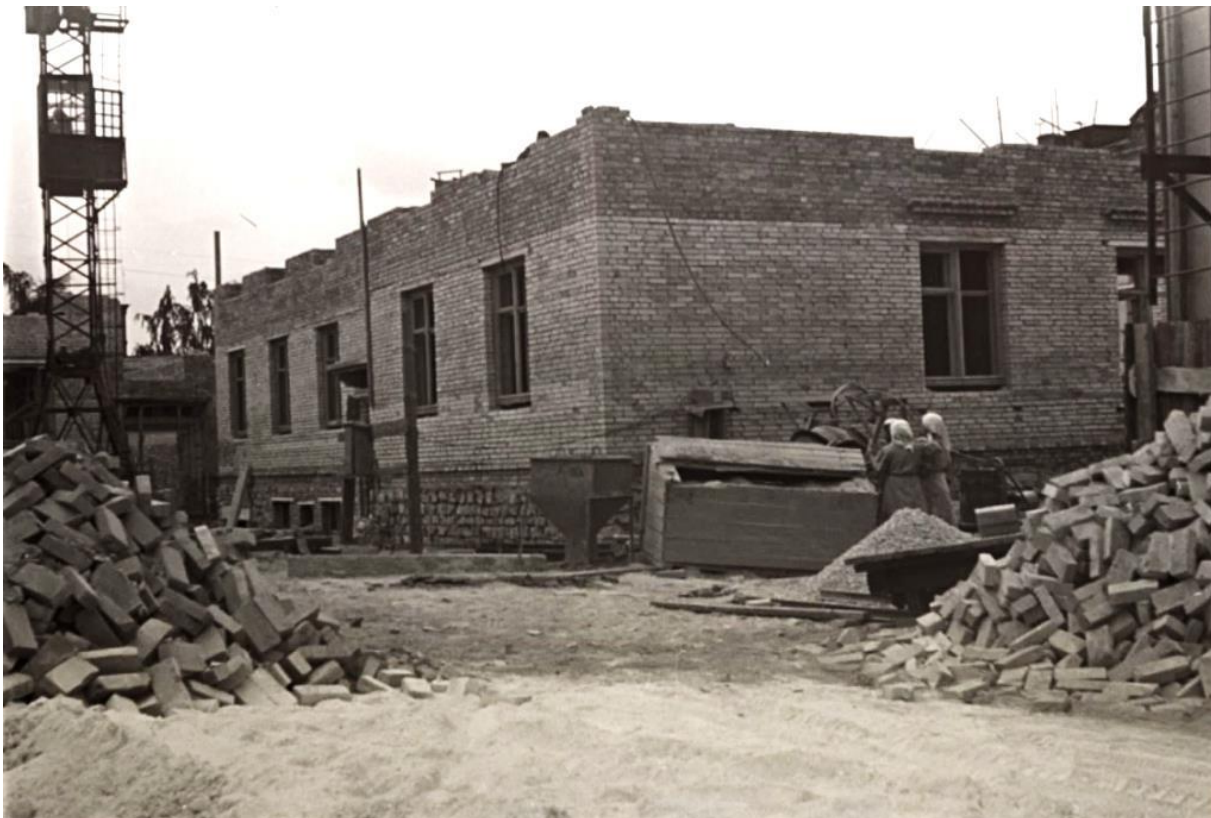
10. Koidu tänav 11 elamu ehitamine. Paremäl esiplaanil näha juba valminud Koidu tänav 9 hoone nurk. Ehitusel hoiavad silma peal kaks valgete rätkidega brigaadi liiget. Sõjajärgses Eestis oli ehitamine vähe mehhaniseeritud, ehituskorraldus primitiivne ja ehitusmaterjalide valik väga piiratud. 17
