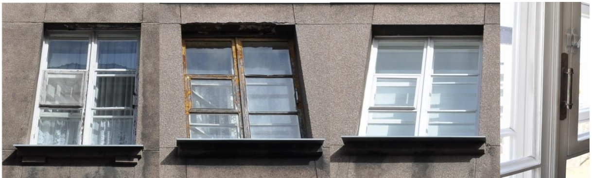
21. Säilinud originaalaknad on erinevas seisukorras. Stalinistlikele majadele on omased väikesed õhutusaknad nn fortotškad. Sisemised raamid on nõgusate profiilidega, mis peegeldavad hästi sissetulevat valgust.
