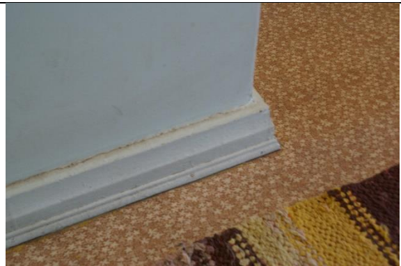
4. Algne linoleumpõrand köögis koos profileeritud piirdeliistudega P5
