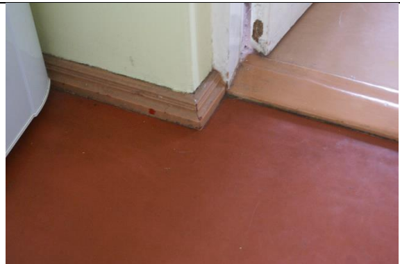
4. Algne linoleumpõrand köögis koos profileeritud piirdeliistudega P5
