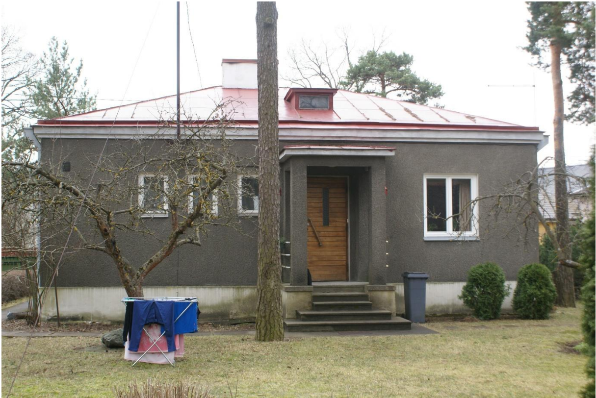
16. Rahumäe tee 21 põhjafassaad
