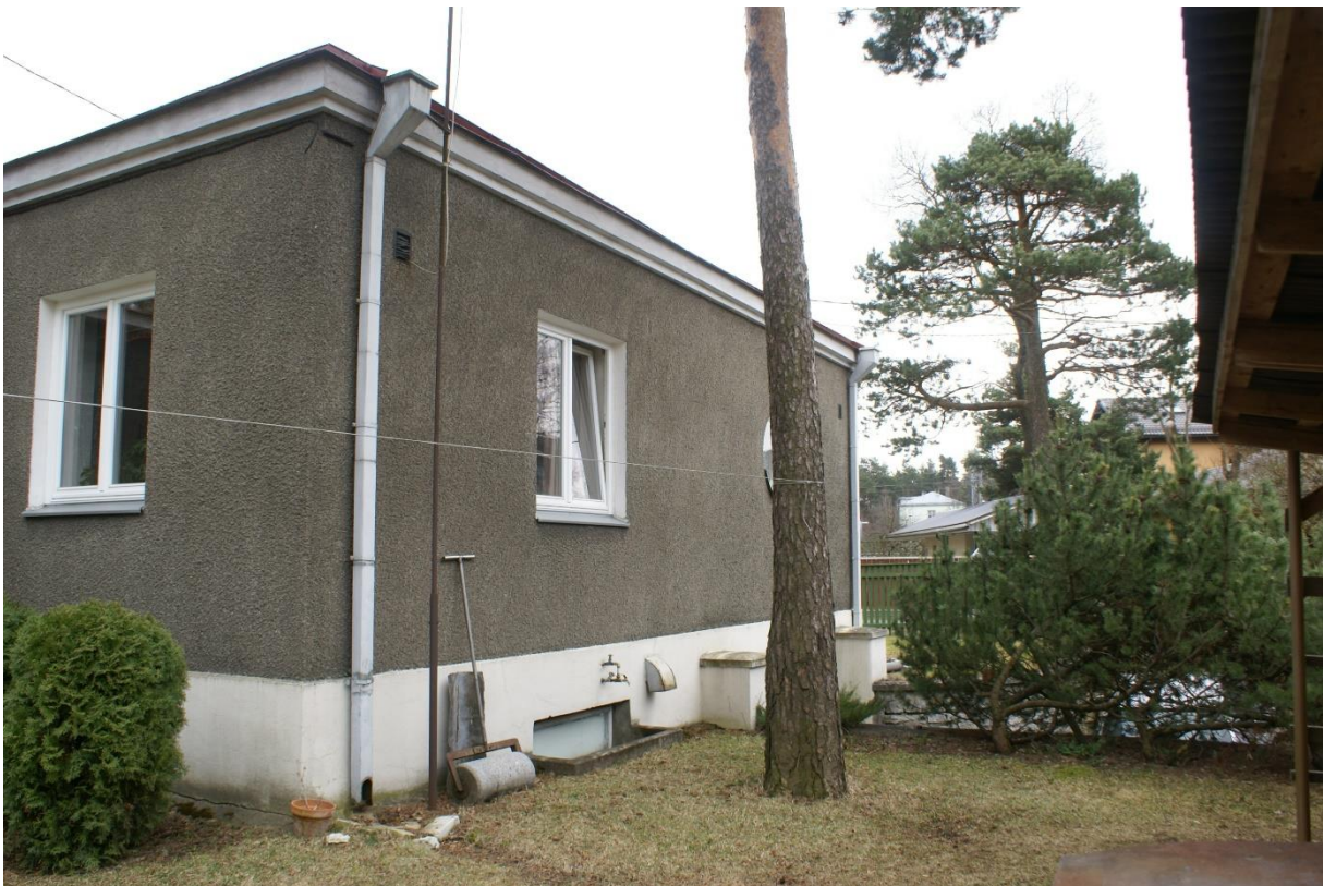
15. Rahumäe tee 21 läänefassaad.
